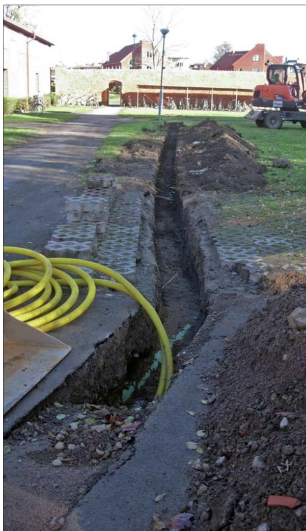
Figur 6. Elledningsschaktet med den återfyllda sträckan närmast i bild. Foto mot öster av Mats Magnusson, ÖM.
