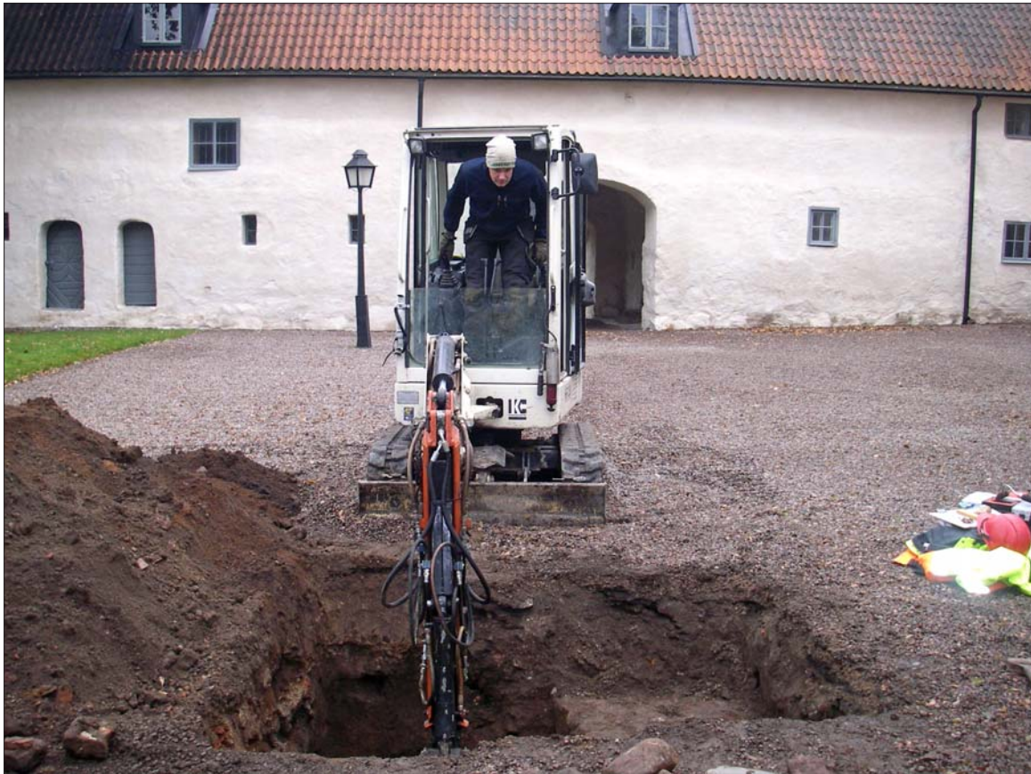
Figur 8. Schaktning för flaggstångsfundament på Biskopsgården. Foto Ann-Charlott Feldt, Östergötlands museum.
