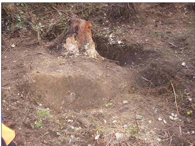
Figur 46. Rotvälta 22, framrensad. Foto: ÖLM.
