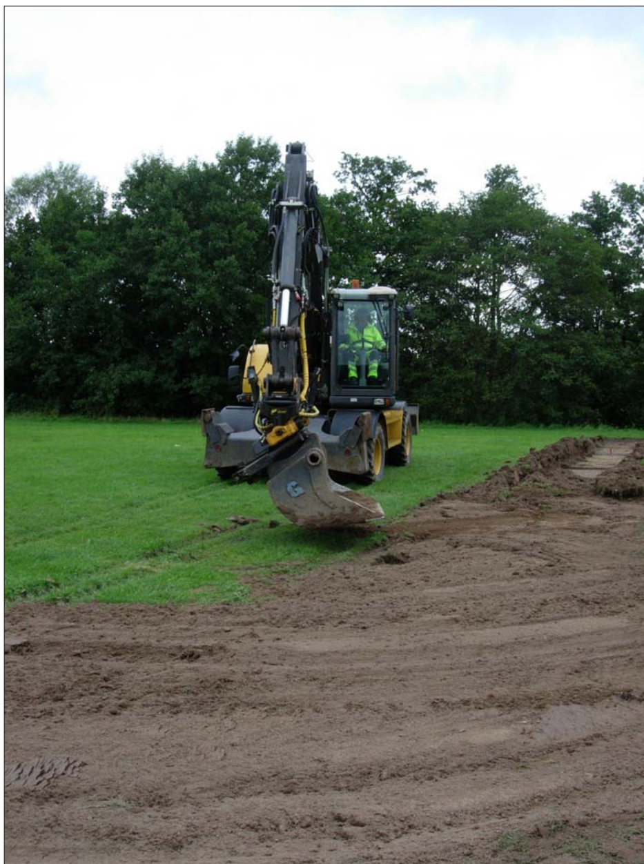
Figur 39. Grävmaskinist Johnny Dalevall lägger igen ett av schakten i delområde 1. Foto: Erika Räf, ÖLM
