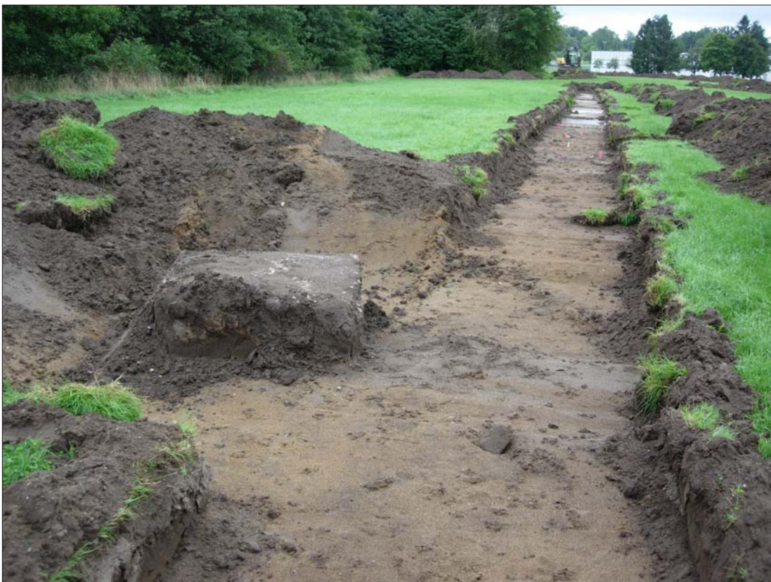
Figur 30. I schakt 8 påträffades bl a ett betongfundament. Mot SÖ. Foto: Erika Räf, ÖLM.
