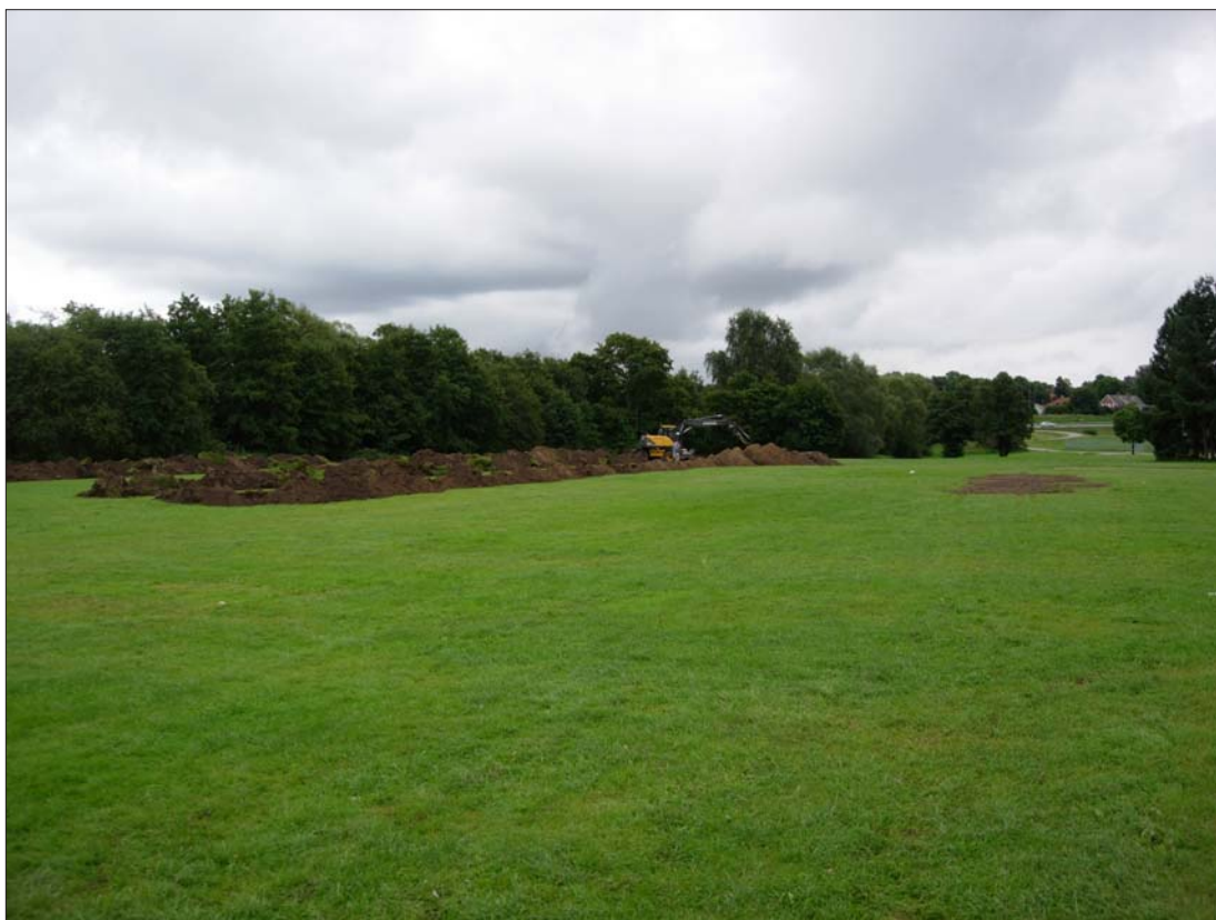
Figur 12. Delområde 1 mot SÖ. Schakt 1 och 3-5 under igenläggning. Foto: Erika Räf, ÖLM
