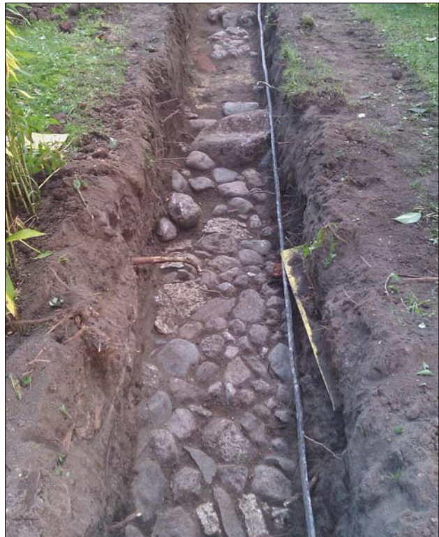
Figur 6a. Stenbeläggningsen i tvärschaktet. Foto Mats Magnusson, ÖLM.
