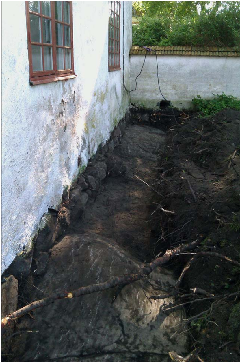
Figur 6. Schaktet utmed den västra gaveln. Foto Mats Magnusson, ÖLM.
