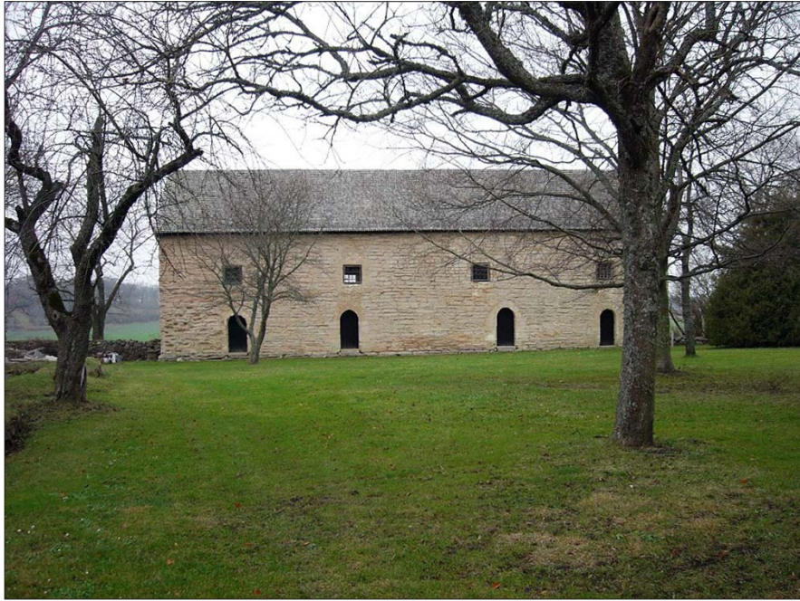
Figur 4. Vreta klostrets spannmålsbod tillväster är uppförd 1289. Det är en påkostad byggnad avsedd att annonsera klostrets rikedom. Foto ÖLM.
