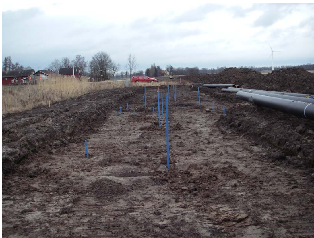
Figur 8. Område A och hus 1 under utgrävning. De blå pinnarna markerar takbärande stolpar. Bilden sedd mot norr. Ekängsvägen löper i bildens vänstra utkant. Husen i bakgrunden är fastigheten Gärstad 3:1. Foto Anna Börjesson, ÖLM.
