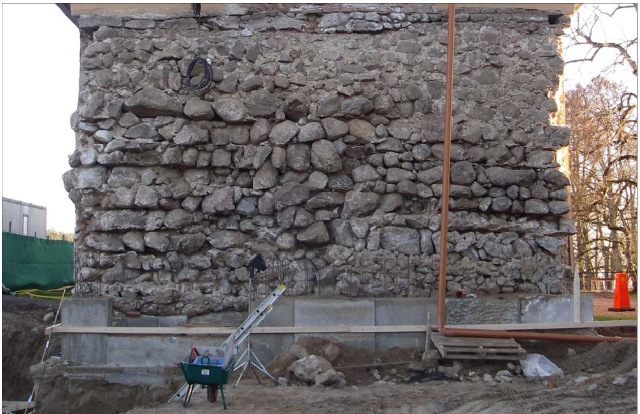
Figur 15. Norra flygelns grundläggning mot väster efter att fyllnadsmassorna har avlägsnats. Arbetet med betongförstärkning av grunden har inletts. Foto Ann-Charlott Feldt, ÖLM.
