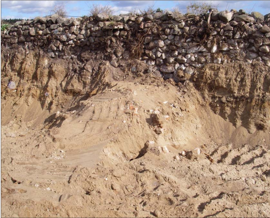
Figur 27. Södra källarens takvalv sticker upp ur fyllnadsmassorna vid schaktning bakom den västra muren. Foto Ann-Charlott Feldt, ÖLM.
