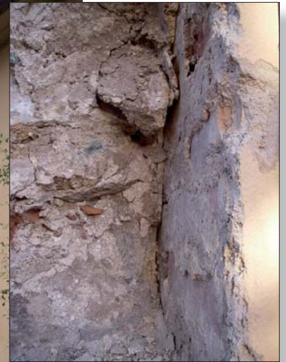
Figur 17. I anslutningen mellan den västra terrassmuren och norra flygeln finns rester av puts som visar att muren tillkommit efter att flygeln byggts. Foto Ann-Charlott Feldt, ÖLM.
