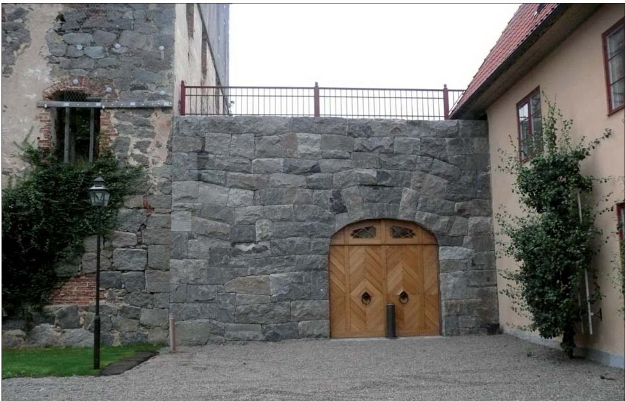
Figur 18. Nya terrassmuren med ingång till den nybyggda delen av slottet. Foto Ann-Charlott Feldt, ÖLM.
