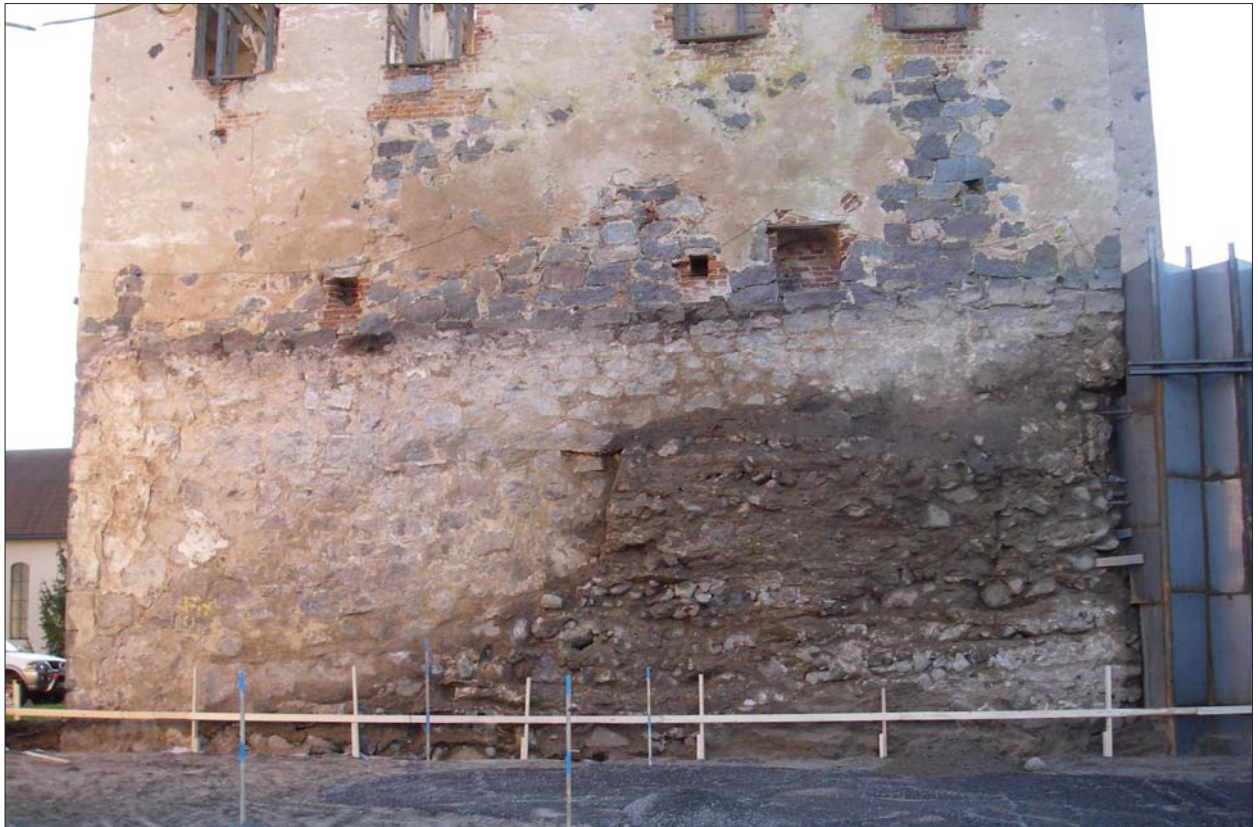
Figur 14. Norra fasaden efter att fyllnadsmassorna avlägsnats. Till höger ser man den oputsade grundmuren på suterrängvåningen och mitt på fasaden kommer den äldsta släntens rand. Foto Ann-Charlott Feldt, ÖLM.
