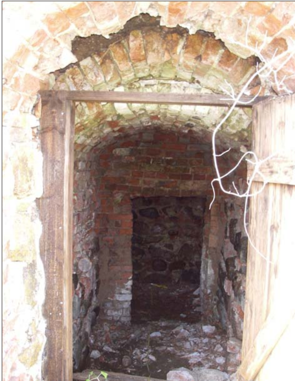
Figur 24. Södra källarens entré i västra terrassmuren. Foto Ann-Charlott Feldt, ÖLM.
