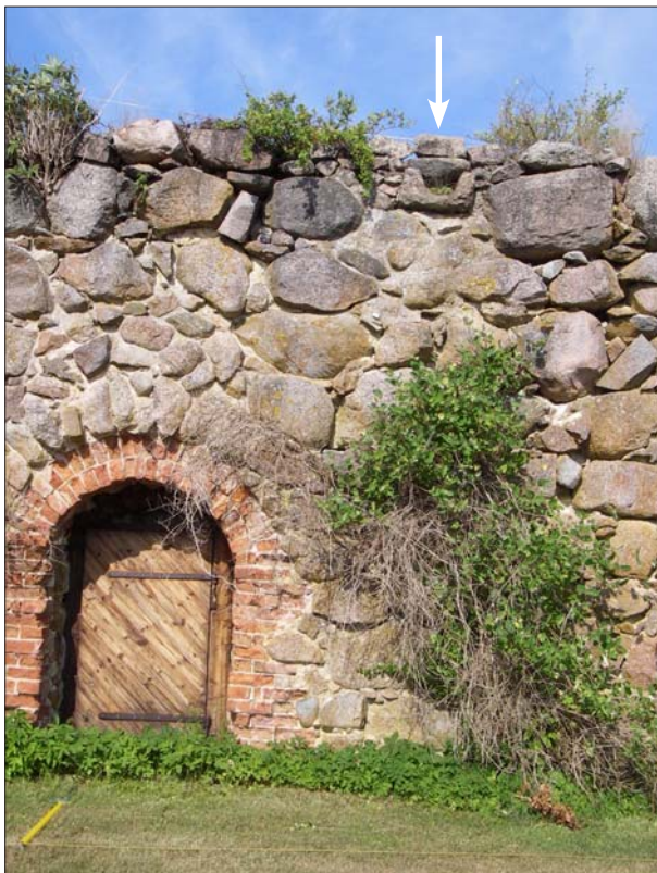
Figur 20. Västra terrassmuren, vid den södra källaren, med vattenkastare (se pil) på murkrönet. Foto Ann-Charlott Feldt, ÖLM.
