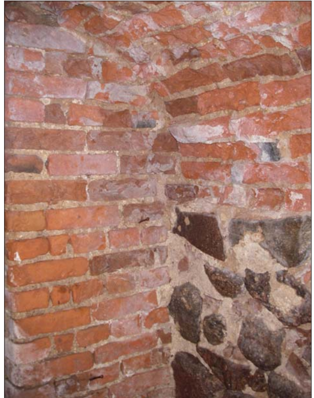
Figur 26. Takvalv och västvägg av tegel i södra källarens inre rum. Foto Ann-Charlott Feldt, ÖLM.
