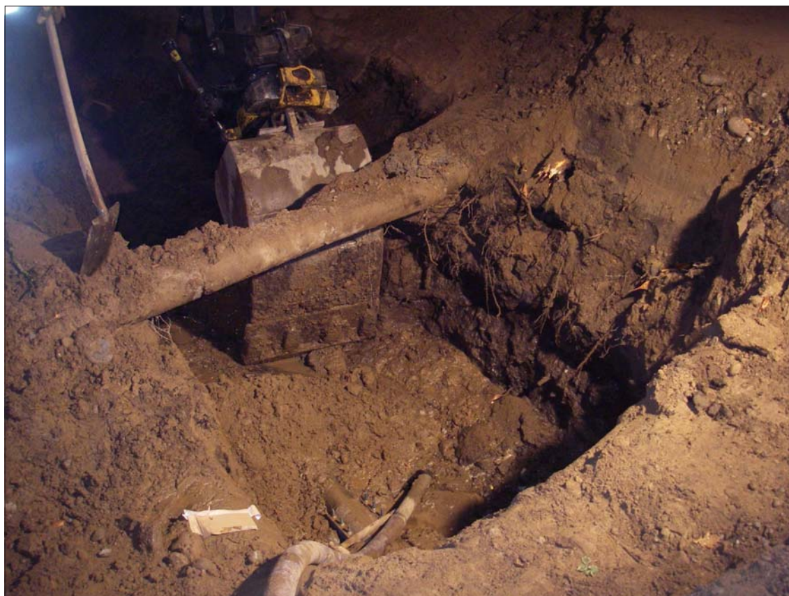
Figur 5. Schaktning för vattenläckan pågår. Foto Ann-Charlott Feldt, ÖLM.
