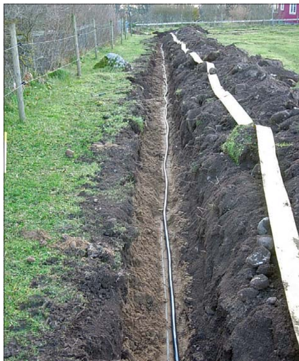
Figur 4. Schaktet mot söder. Den äldre kabeln syns under den nya. Foto Mats Magnusson, ÖLM.
