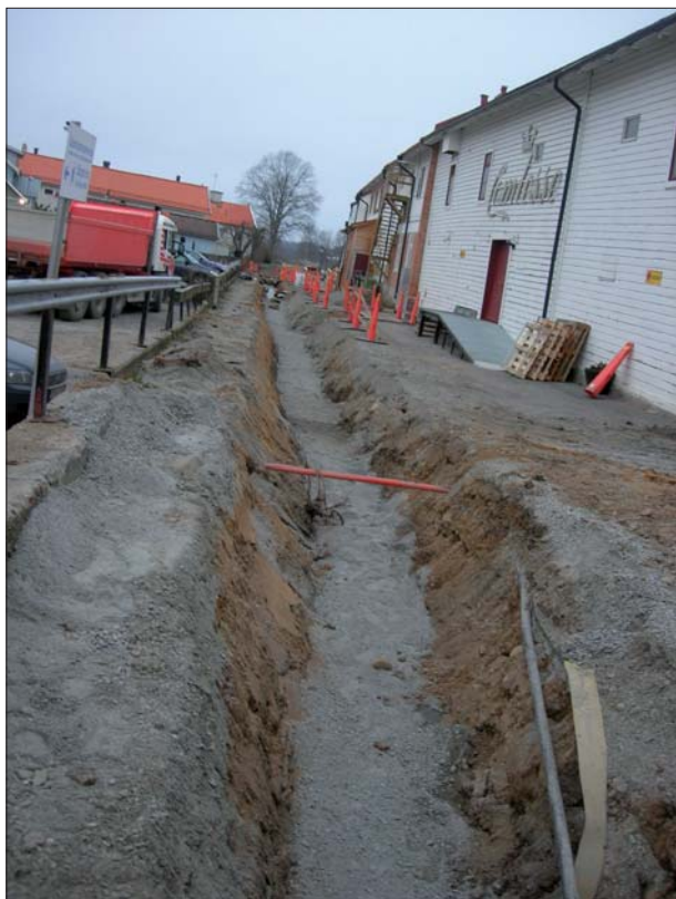
Figur 13. De kulturlager bakom Kanalmagasinen som kom att beröras av fjärrvärmeschaktet bestod till stor del av modernare utfyllnadslager. Längre ned i marken kan dock medeltida lager fortfarande förekomma. Foto Christer Carlsson, ÖLM.
