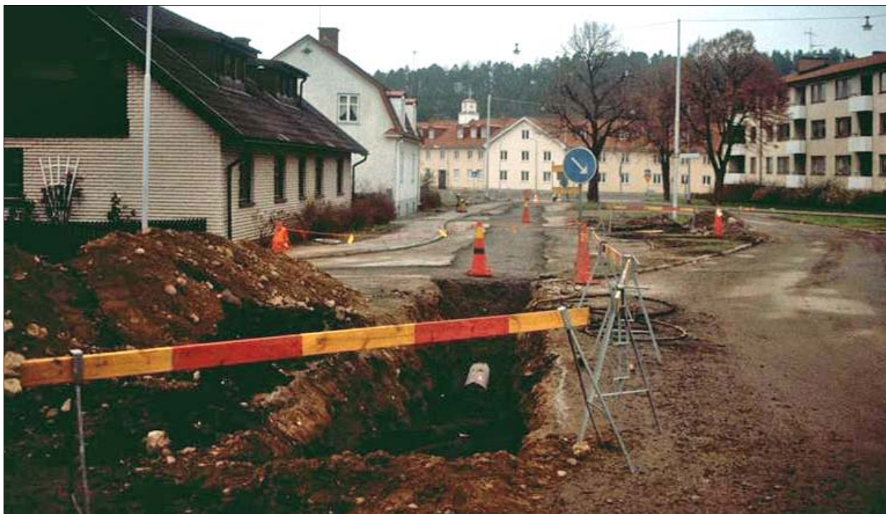
Figur 8. Vintervadsplan under pågående schaktning. De två husen till vänster ligger i kv Vintervadet. På höger sida skimtar kv Gillet och rakt fram i bild kv Norrtull. Foto mot NNÖ.
