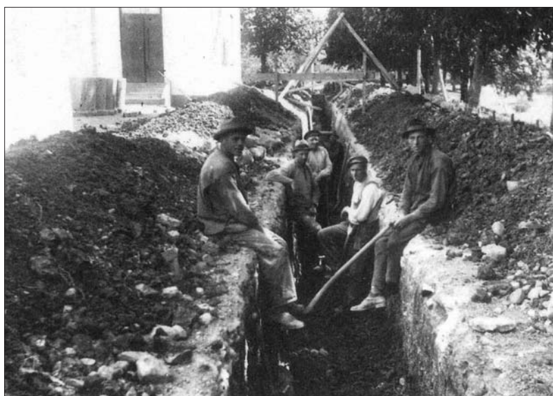
Figur 11. Schaktningsarbeten på 1920-talet skedde helt för hand och schakten blev därför så smala som möjligt. Från dem föreligger en del bilder tagna av den klassiska Söderköpingsfotografen Emil Ström. Här en vilopaus vid grävning i Ågatan.
