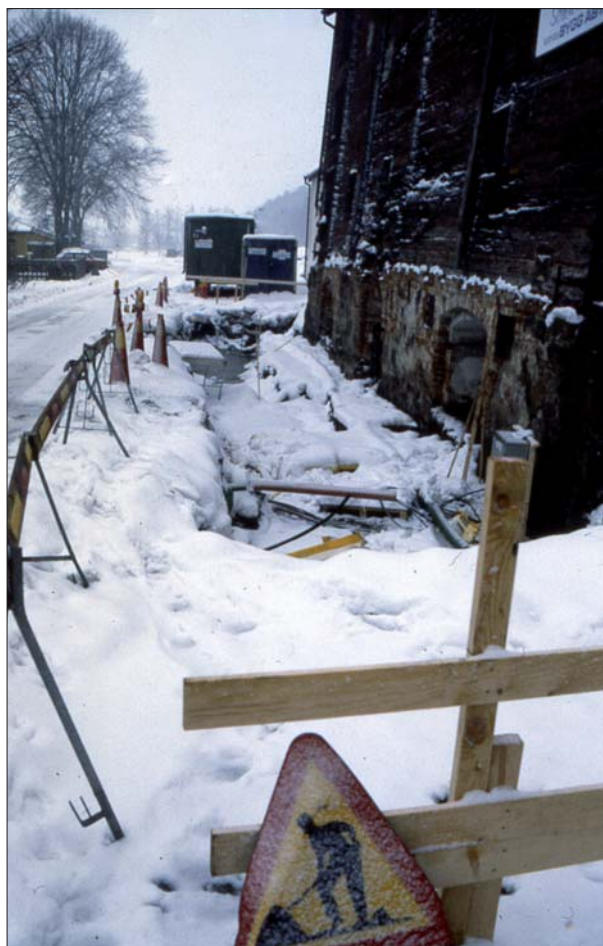
Figur 9. Kanalmagasinsschaktet en decembermorgon. Foto ÖLM.
