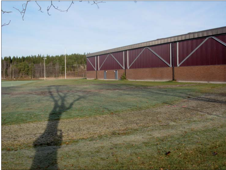
Figur 6. Schakt väster om sporthallen, foto mot nordöst. Foto ÖLM.
