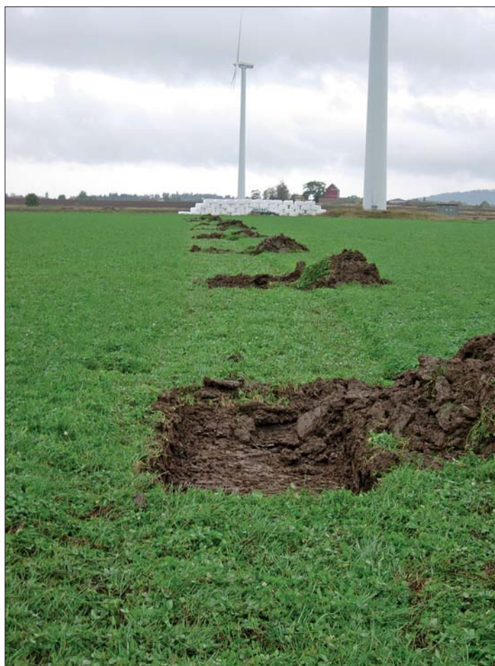
Figur 4. Schakten längs den södra sträckningen, mot väster. Foto ÖLM.
