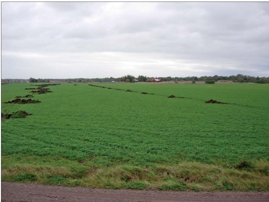
Figur 10. Schakten längs såväl den norra som södra sträckningen för tillfartsvägen. Översiktsbild mot sydost. Foto ÖLM.
