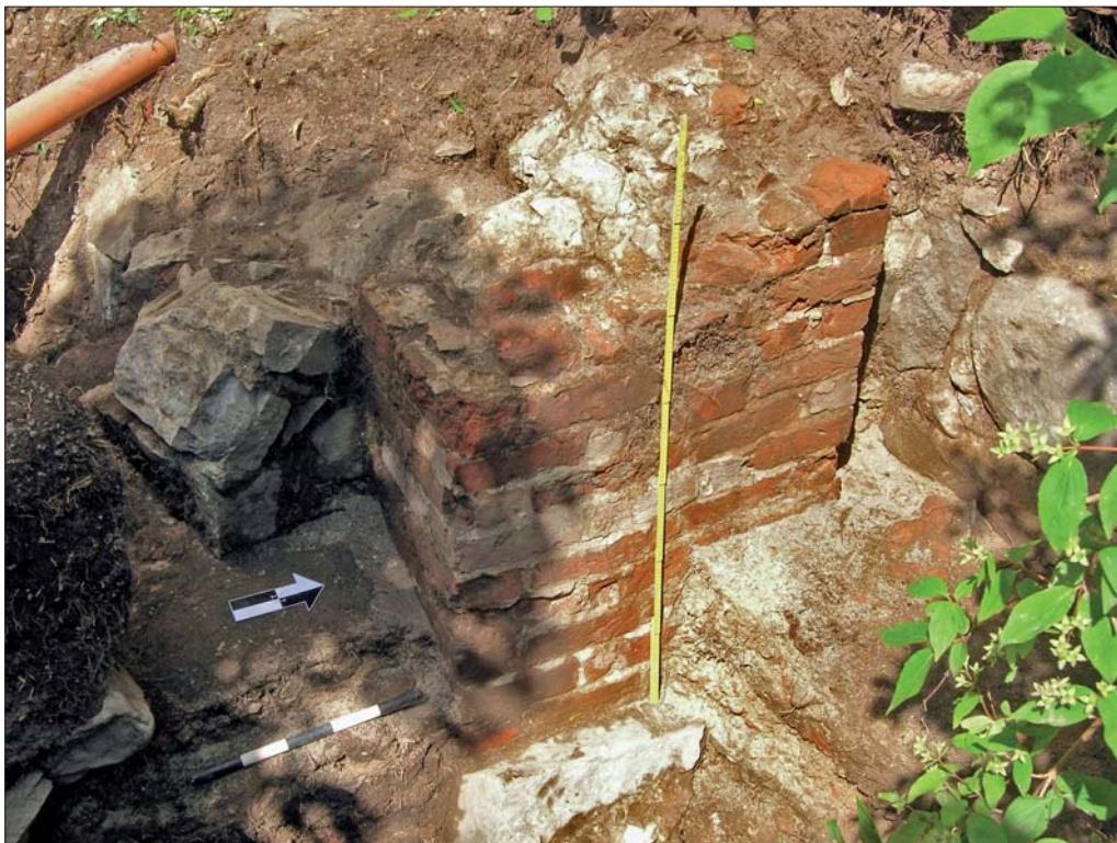
Figur 8. Strävpelaren av tegel vilade på ett stenfundament som i syn tur vilade på medeltida raseringslager. Tegelgolvet i källaren gick in under dessa raseringslager.
