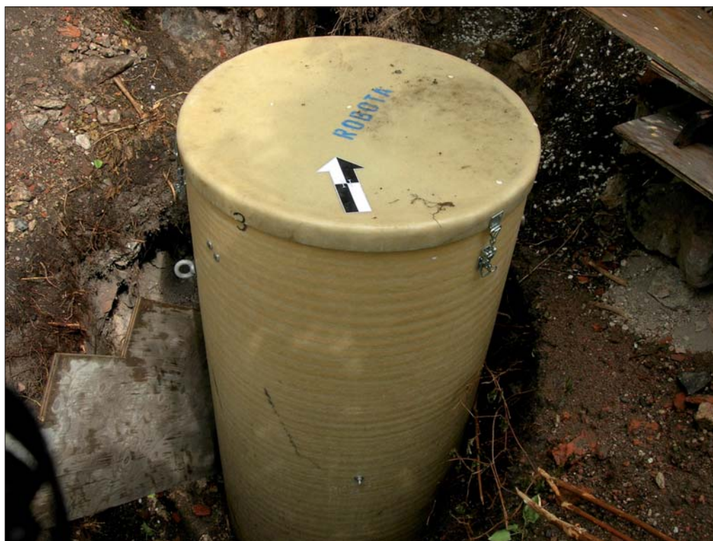
Figur 5. VA-tanken var placerad i schaktets centrala del då undersökningen påbörjades. Ett flertal kulturlager och murar hade skadats då hålet för tanken grävdes. Foto Christer Carlsson, ÖLM.
