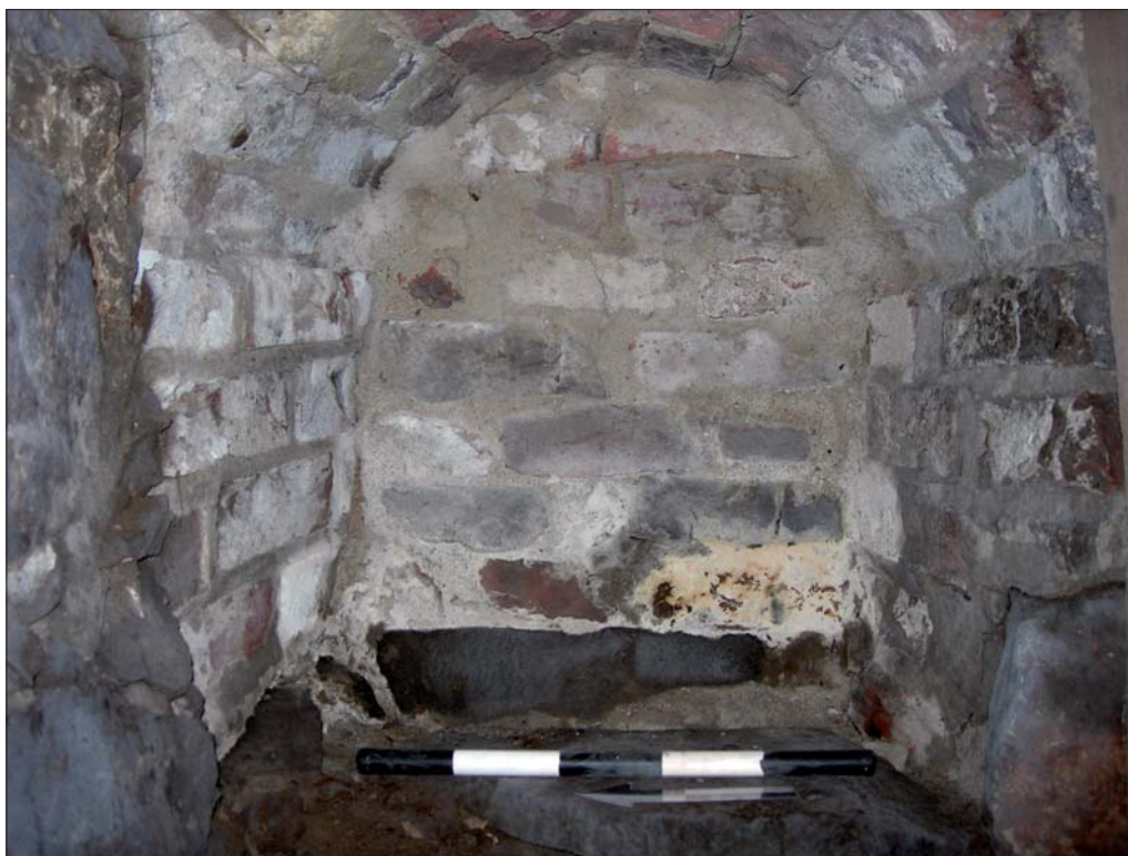
Figur 13. Igenmurat fönster i den medeltida källaren under bostadshuset på tomten. Foto Christer Carlsson, ÖLM.
