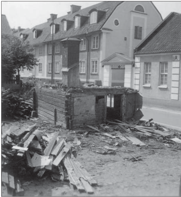
Figur 7. Rivning av Nygatan 10. Delar av den äldre bebyggelse som fanns kvar i Linköping fram till dess att den stora stadsomvandlingen började under efterkrigstiden. Foto ÖLM.
