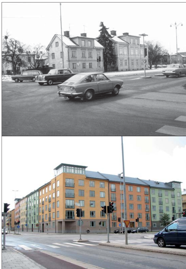
Figur 18. Foto av hus i kv Drabantens längs Hamngatan. Undre bilden tagen 2007. Foto ÖLM, Topografiska arkivet.
