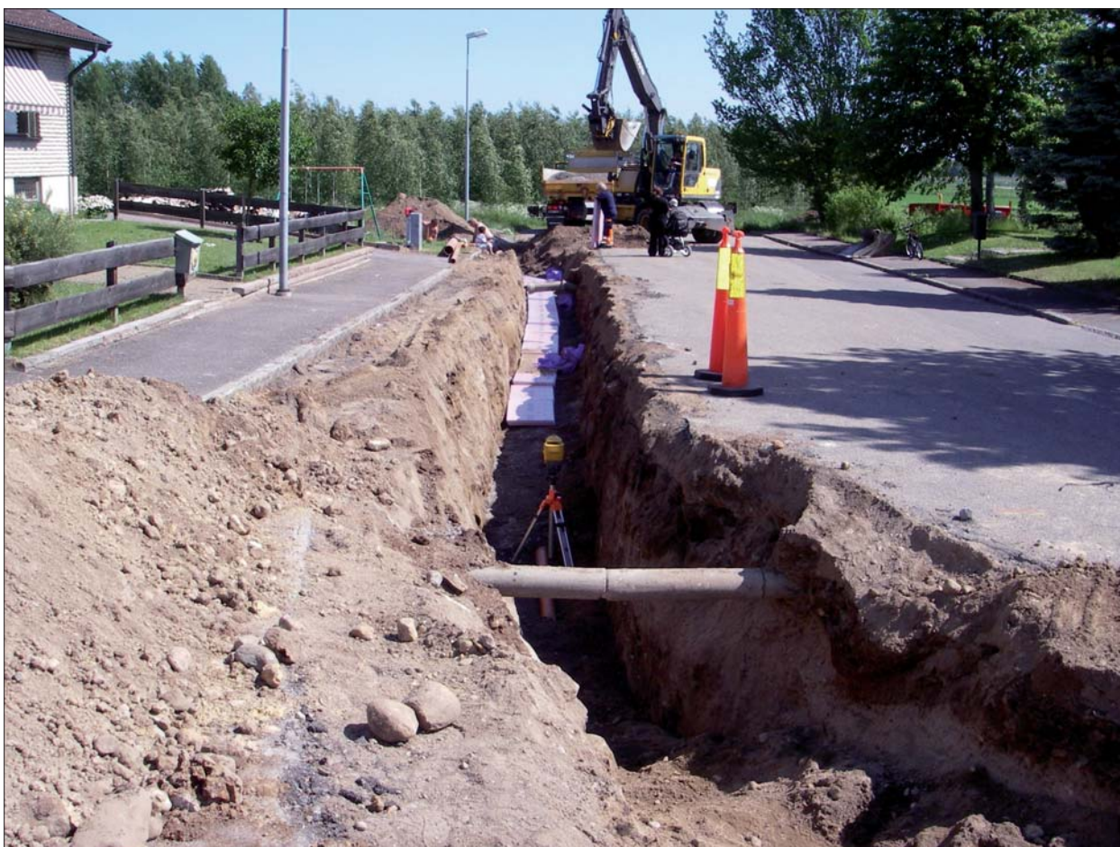
Figur 5. Schaktet för VA-anslutningen mot nordöst. Foto Christer Carlsson, ÖLM.
