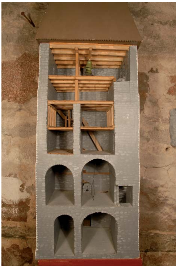
Figur 16. Modell av Bjälbo kyrktorn som Jan Eriksson tänker sig våningsindelningen. Mats Gilstring har tillverkat modellen, som finns utställd i Bjälbotornet. Foto Lars Ekelund.
