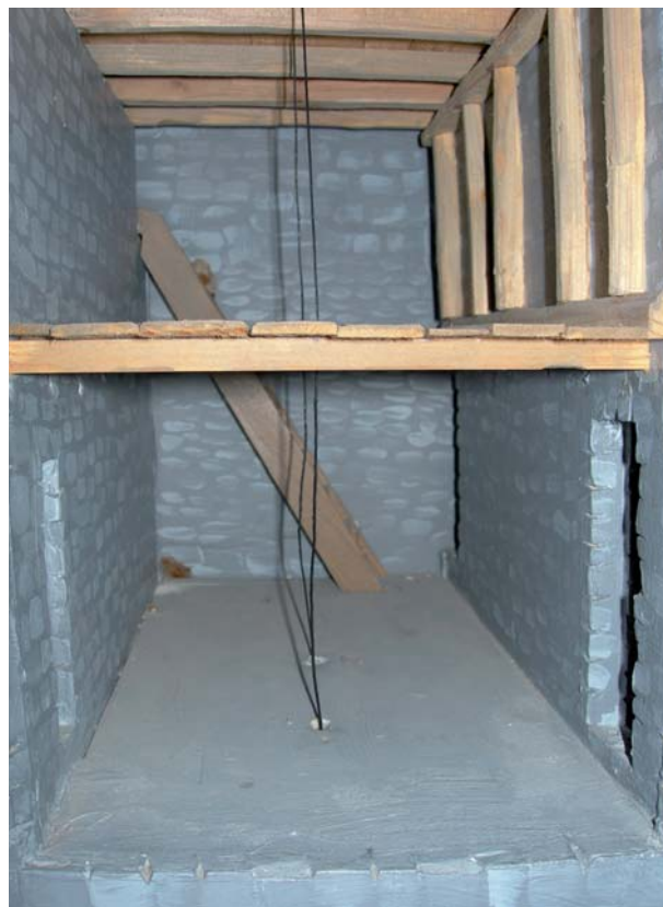
Figur 24. Detalj av tornmodellens tredje våningsplan. Modellen visar dock endast två av tre konstaterade hål för klocklinor. Foto Marie Ohlsén, ÖLM.
