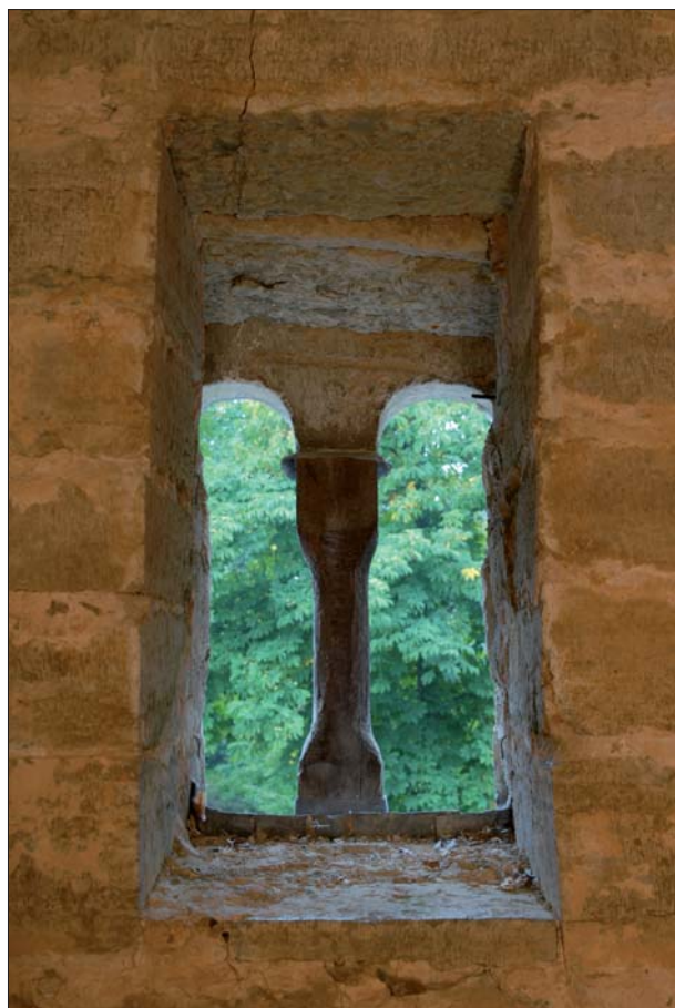
Figur 8. Fönstret till den lilla kammaren på andra våningen är försett med fint arbetad sten. Rummet brukar kallas Ingrid Ylvas kammare. Foto Lars Ekelund.
