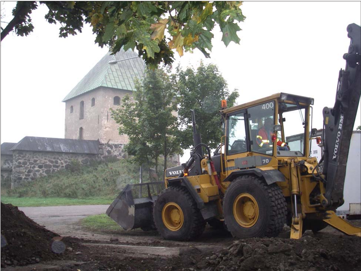
Figur 6. Schaktning pågår intill Johannisborgs porttorn. Foto Ann-Charlott Feldt, Östergötlands länsmuseum.
