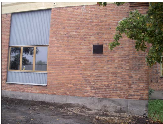
Figur 7. Den väggyta på lokstallet som berördes av den aktuella utbyggnaden. Foto Ann-Charlott Feldt, Östergötlands länsmuseum.
