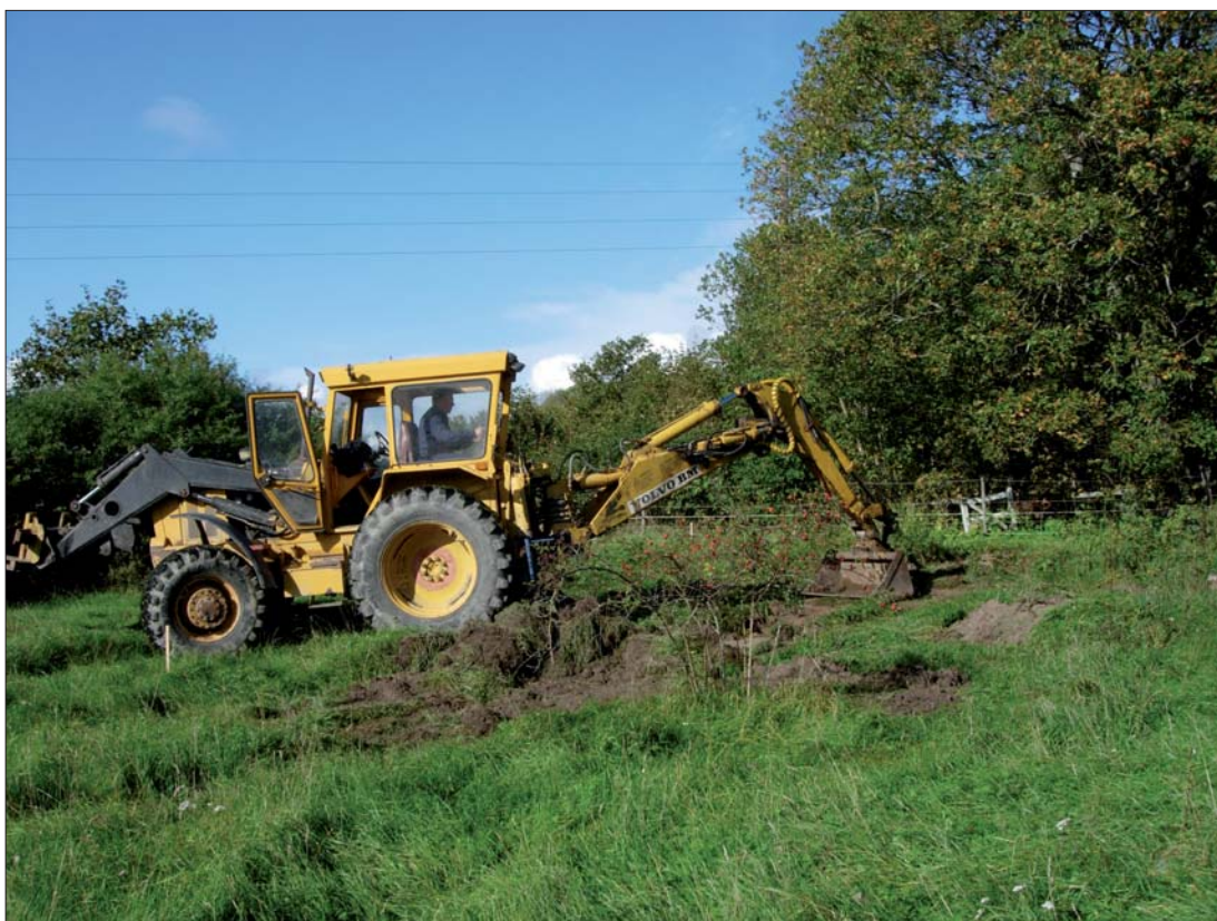
Figur 3: Schaktningsarbete där huset planeras byggas. Foto taget mot väster. Foto Mattias Schönbeck, ÖLM.
