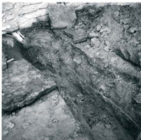
SÖ korsgången Ledningsschakt fr. NV.
