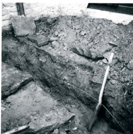
SÖ korsgången. Ledningsschakt fr. NV.
