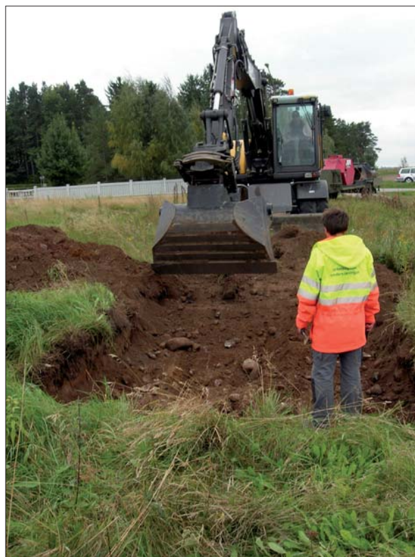
Figur 3. Kjell Svarvar och grävmaskinist schaktar i det steniga moränpartiet i sydöst. Foto: Erika Räf, ÖLM.
