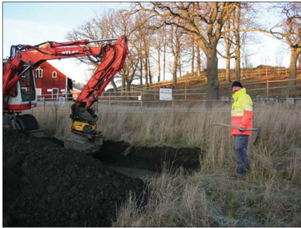
Figur 6. Schaktarbete vid objekt 10. Foto Rickard Lindberg, ÖLM.
