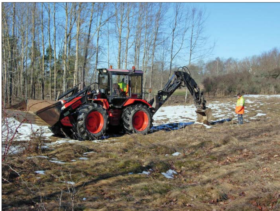
Figur 5. Schaktning vid RAÄ 84. Foto Clas Ternström, ÖLM.
