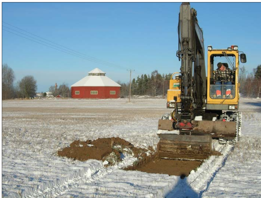
Figur 4. Arbetsbild. Magnus Lanshed tar upp ett sökschakt. I bakgrunden syns byggnadsminnet Sörby rundloge i vinterskrud. Foto: Anders Lundberg, ÖLM.
