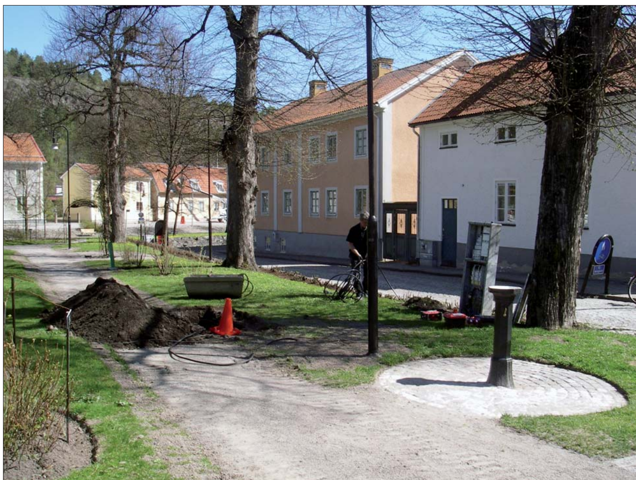
Figur 6. Det södra schaktet med det sluttande kvarteret Bryggaren i bakgrunden till vänster. Foto Ann-Charlott Feldt, Östergötlands museum.
