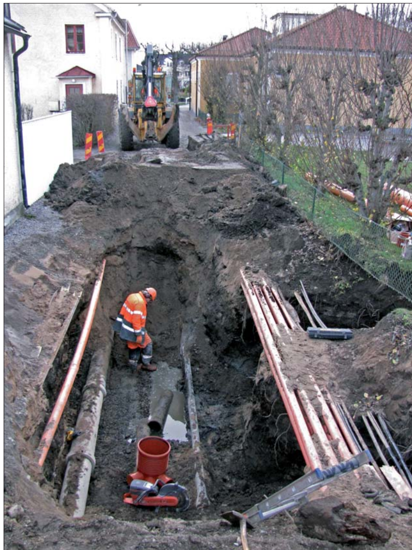
Figur 4. Det större schaktet i Kanalgatan berörde en sedan tidigare undersökt sträcka. Till höger i bild syns de två mindre schakten som omfattades av den nu aktuella undersökningen. Foto mot SV, Emma Karlsson, ÖM.
