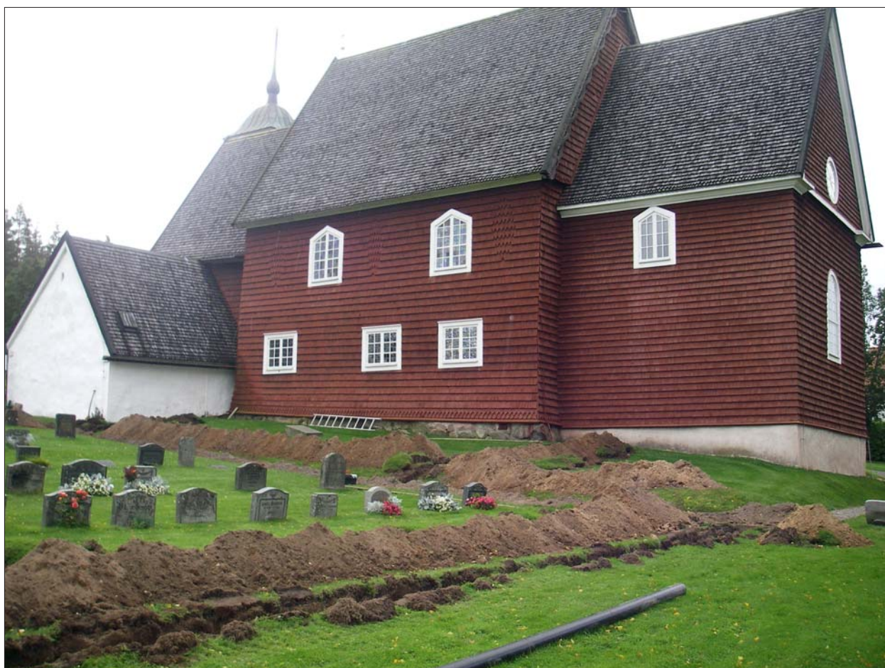
Figur 7. Ledningsschaktet på kyrkans norra sida sett från nordväst. Foto Ann-Charlott Feldt, Östergötlands museum.
