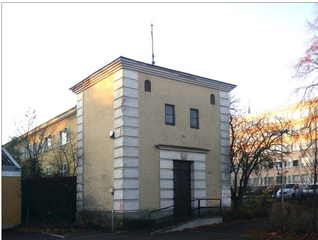
Figur 19. Transformatorstationen från nordost. Foto Marie Hagsten, Östergötlands museum.
