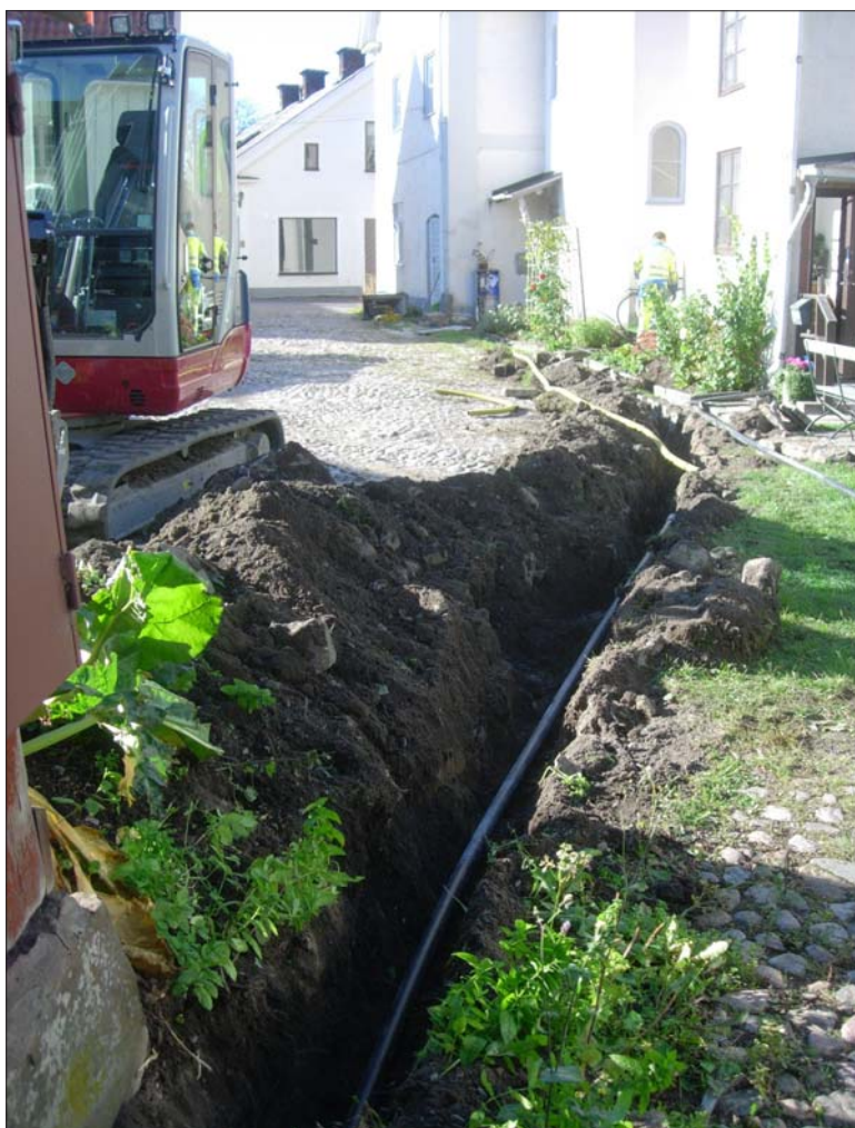
Figur 4. 2011 års schakt mot väster. Foto Mats Magnusson, ÖLM.
