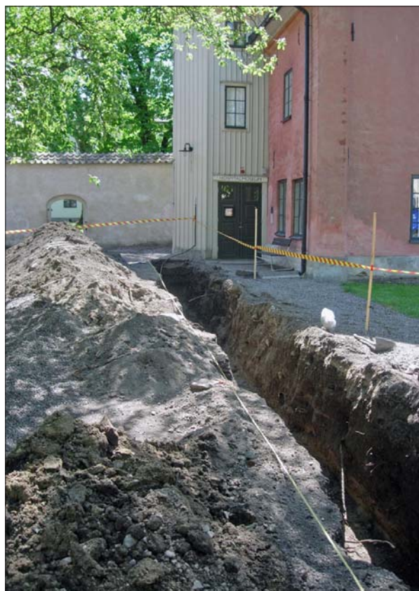
Figur 16, ovan. Schaktet utanför entrén till Hospitalsmuseet. Foto Mats Magnusson, mot SSV.
