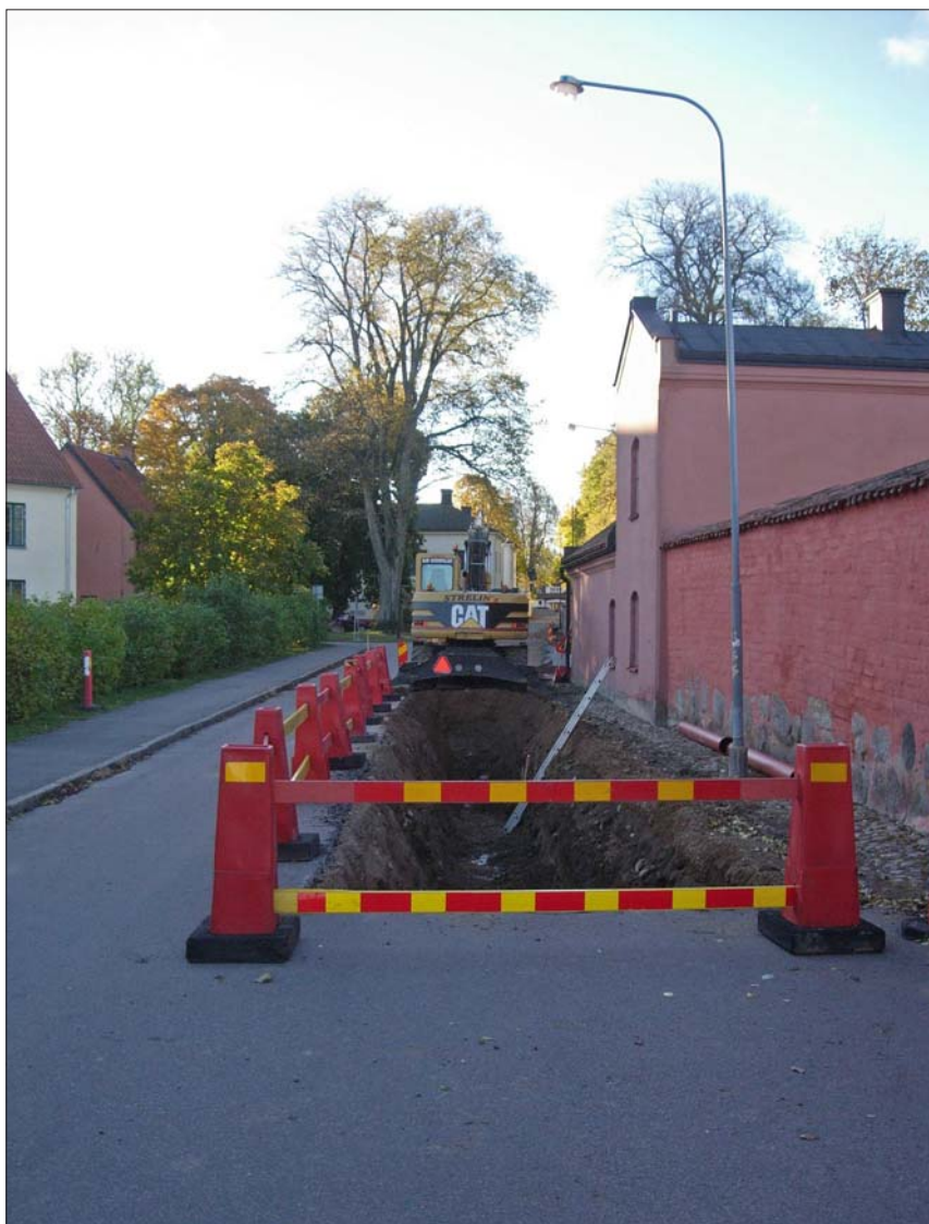
Figur 3. Lastköpingsgatan. Schaktets början i norr, mot sydsydöst. Foto Mats Magnusson.
