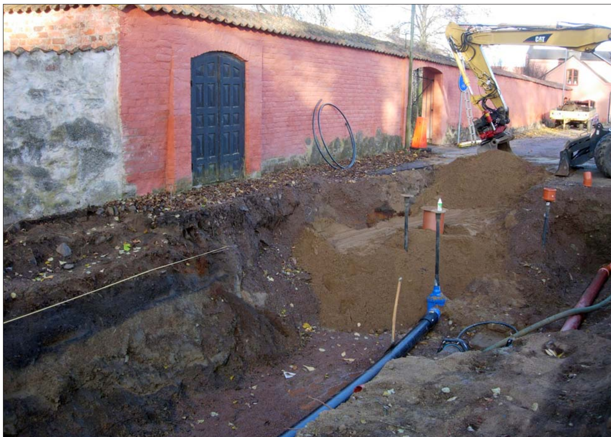
Figur 10. Ett större område schaktades upp strax söder om korsningen Lastköpingsgatan – Jungfrustigen, mot nordväst. Foto Mats Magnusson.
