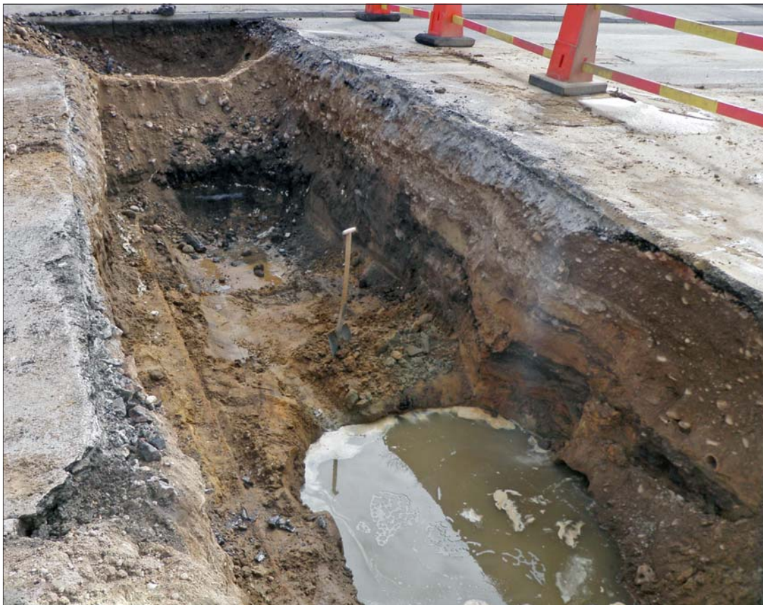
Figur 5. Schakt 2. Under asfalten syns flera olika påfödda grus/gatulager. Den stenlagda gatan ligger som en mörk sträng i mitten av profilen. Underst det mörka kulturlagret. Foto Olle Hörfors.
