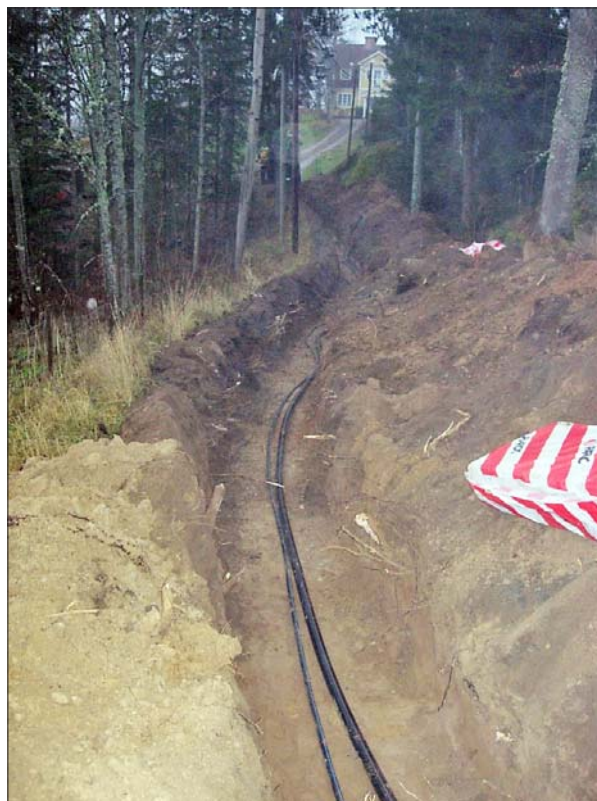
Figur 8. Ledningsschaktet längst upp på bolmen, mot NNV. Foto Mats Magnusson, ÖLM.
