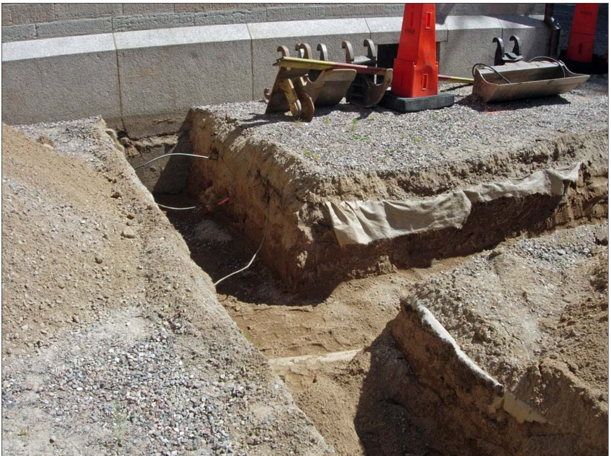
Figur 11. Schaktets anslutning till klosterkyrkan. Foto Mats Magnusson, ÖM.
