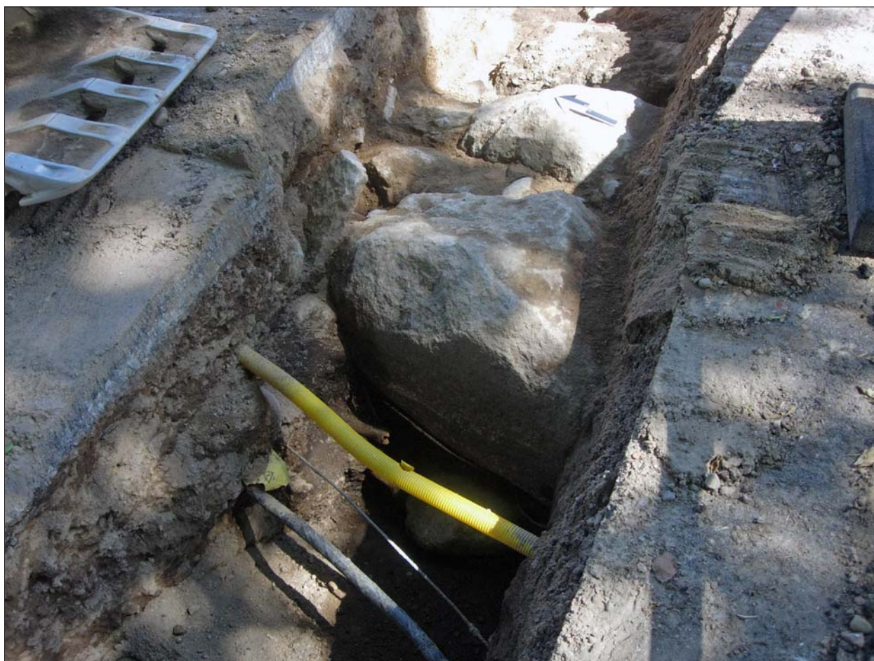
Figur 8. Den påträffade grundmuren till klostermuren, mot ÖNÖ. Foto Mats Magnusson, ÖM.
