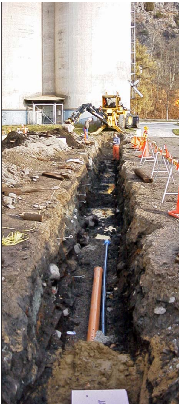
Figur 5. Schaktet mot nordöst med silobyggnaden i bakgrunden. Foto Marie Ohlsén, ÖLM.
