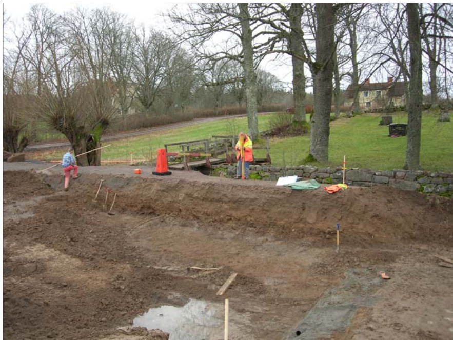
Figur 14. Schakt 4 med kavelbron avlägsnad. Sörby gamla kyrkogård i bakgrunden. Foto ÖLM.
