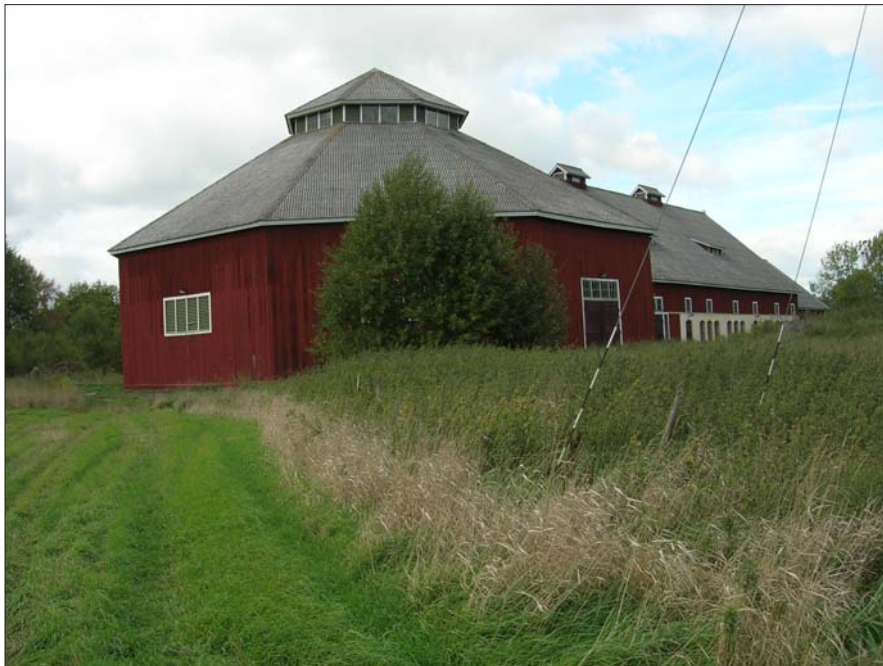
Figur 6: Rundloggen i Sörby är byggnadsminne. Mot N. Foto ÖLM.
