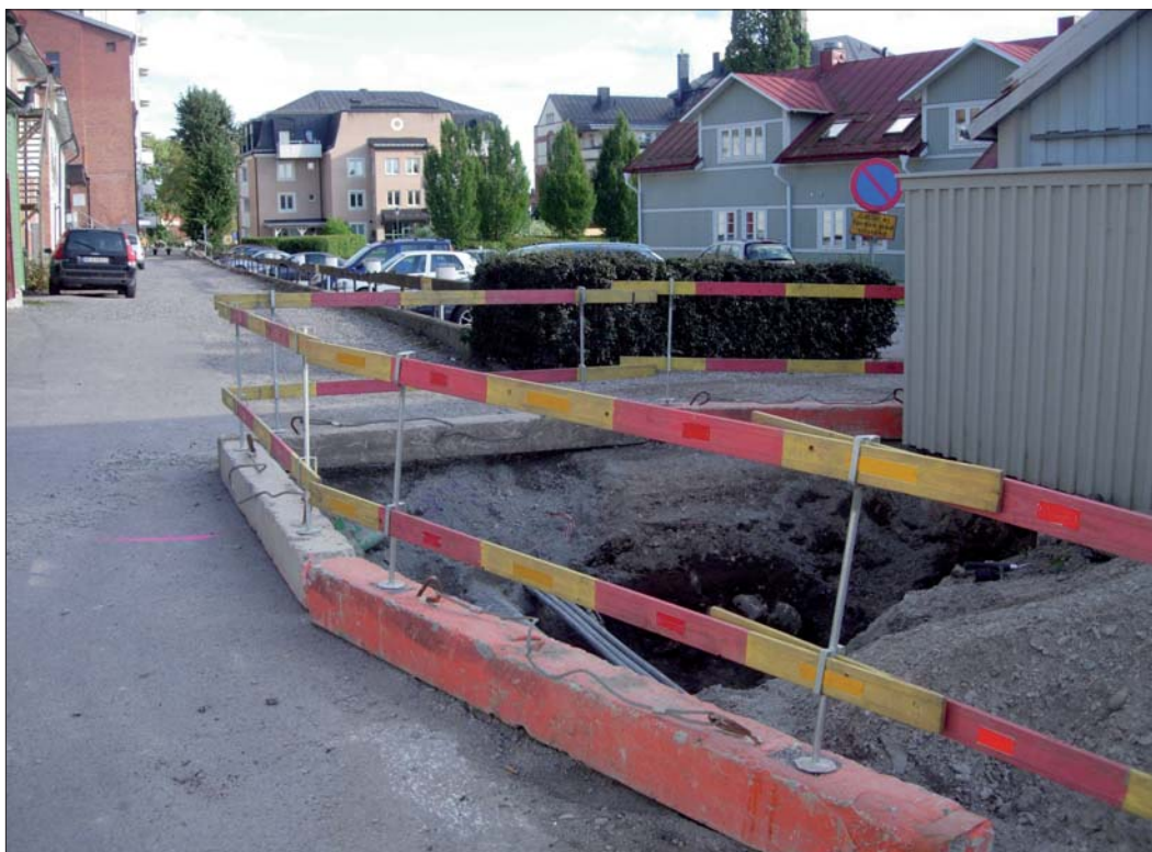
Figur 5. Schaktet i korsningen Bergsvägen och Badstugränd. Foto Mats Magnusson, ÖLM.
