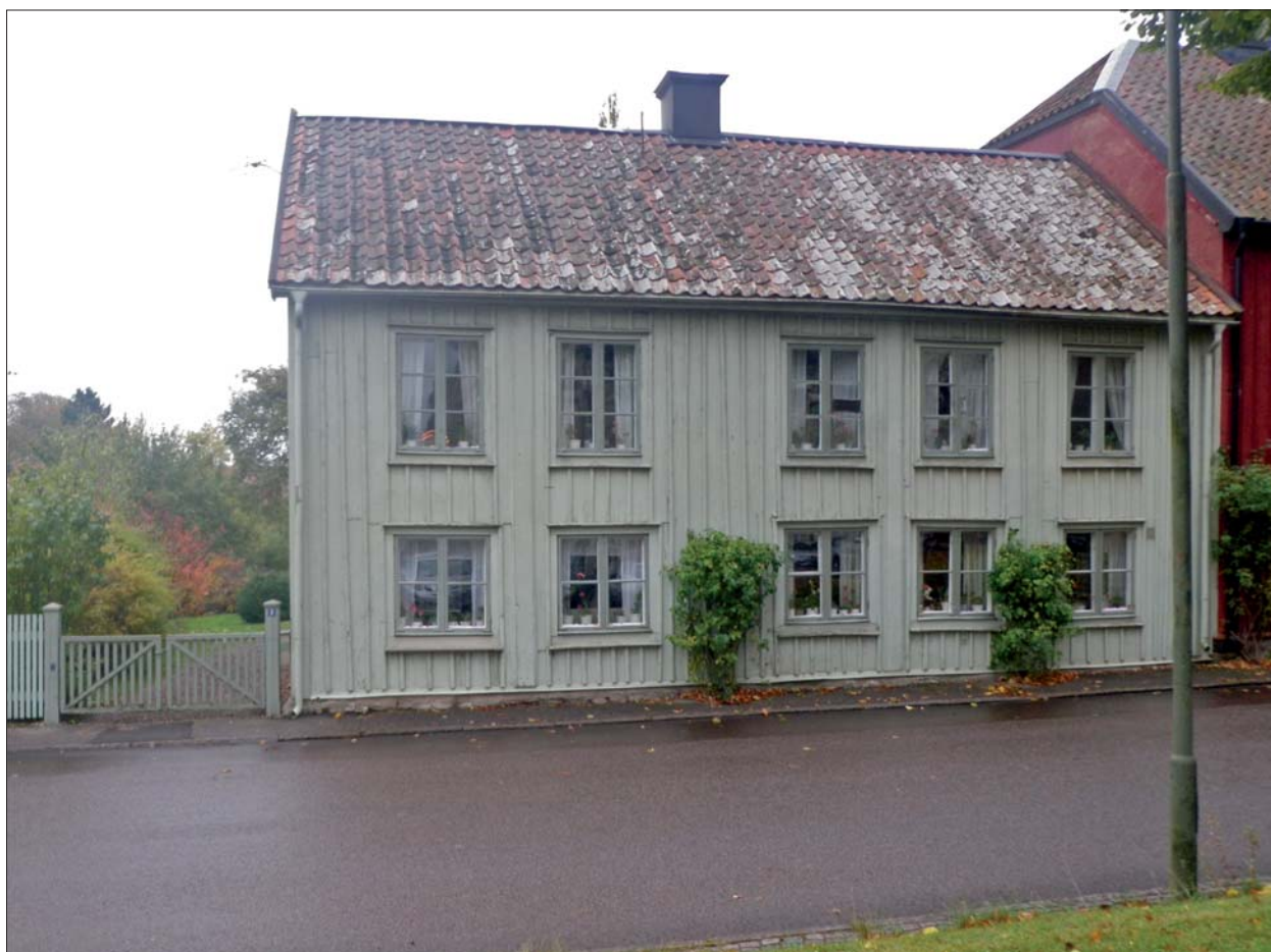
Figur 4. Huset på Kyrkogatan 3. Schakt 1 upptogs i gatan framför huset. Schakt 2 löpte tvär över gatan och in genom grinden och sedan runt huset och in på dess baksida. Huset är sannolikt uppfört på 1600- eller 1700-talet med en nyttillbyggd övervåning från 1800-tal. Lägg märke till den låga takhöjden på undervåningen och den betydligt högre takhöjden på övervåningen, typisk för de olika tidsperioderna. Foto Olle Hörfors, ÖLM.
