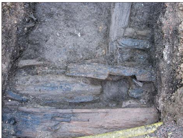
Figur 8. Detalj av tvärgående stock och skadat urtag i syllstock. Foto Mats Magnusson, ÖLM.
