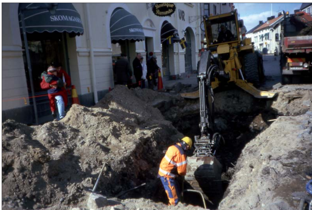
Figur 4. Schaktet längs Storgatan, fotat från sydöst. Foto Marie Ohlsén, ÖLM.
