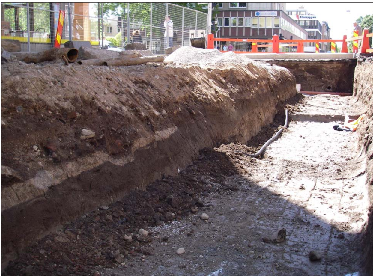
Figur 9. Lagerföljden i den östra schaktväggen i schaktet för fjärrkyleledningen. Fotot visar lagerföljden utanför McDonalds på S:t Larsgatan. Foto Ann-Charlott Feldt, ÖLM.
