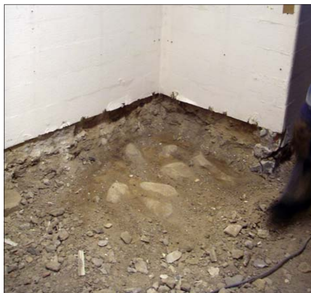
Figur 12. Senmedeltida spisfundament (fundament 2) under golvet i tegelhusets bottenvåning. Foto Ann-Charlott Feldt, ÖLM.
