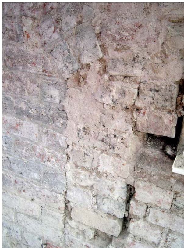
Figur 10. Spår av en fönsteröppning i tegelhusets fasad mot Storgatan. Foto Ann-Charlott Feldt, ÖLM.
