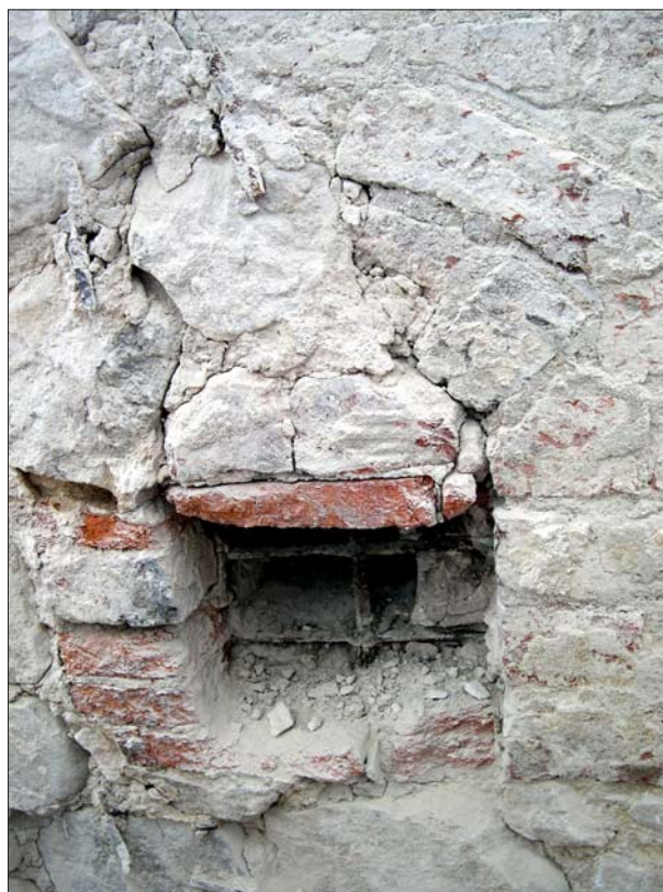
Figur 9. Spår av en fönsteröppning i tegelhusets fasad mot Hovsgatan. Foto Ann-Charlott Feldt, ÖLM.
