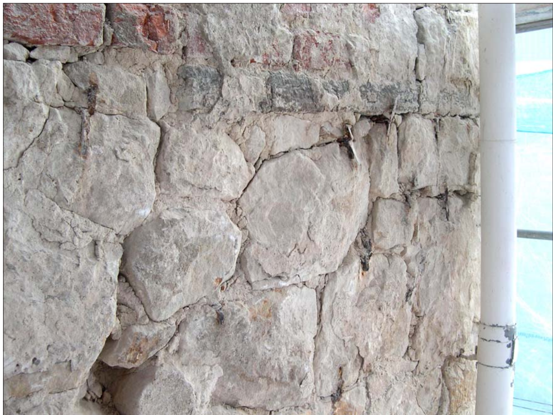
Figur 14. Sandstenslagningens anslutning till det äldre tegelmurverket. Foto Ann-Charlott Feldt, ÖLM.
