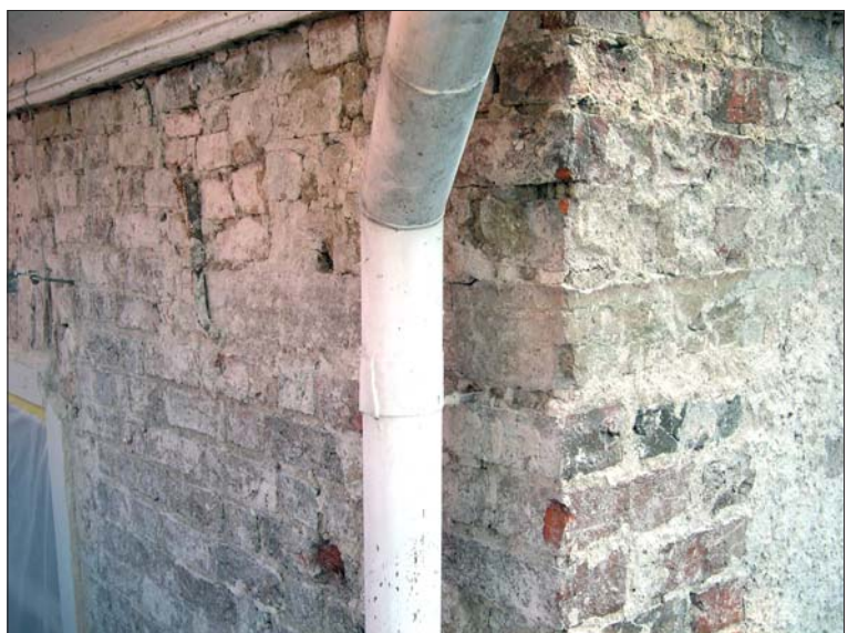
Figur 21. Lagning av det senmedeltida tegelmurverket högst upp i det västra hörnet. Foto Ann-Charlott Feldt, ÖLM.
