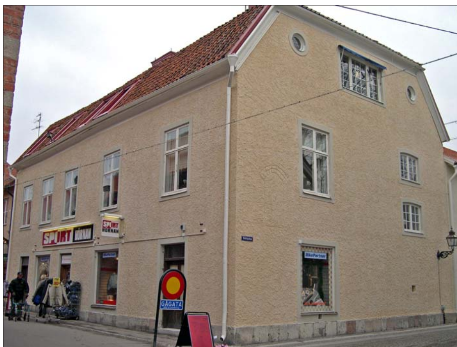
Figur 25. Den omputsade fasaden sedd från hörnet Storgatan-Hovsgatan i väster. Foto Ann-Charlott Feldt, ÖLM.
