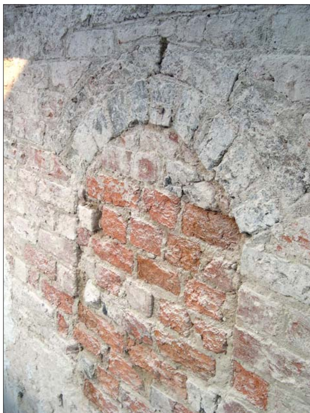
Figur 8. En välbevarad fönsteröppning i tegelhusets fasad mot Hovsgatan. Foto Ann-Charlott Feldt, ÖLM.
