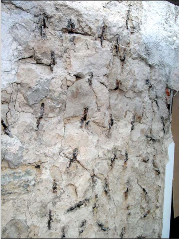
Figur 13. Lagning med kramlad sandstensfasad. Foto Ann-Charlott Feldt, ÖLM.
