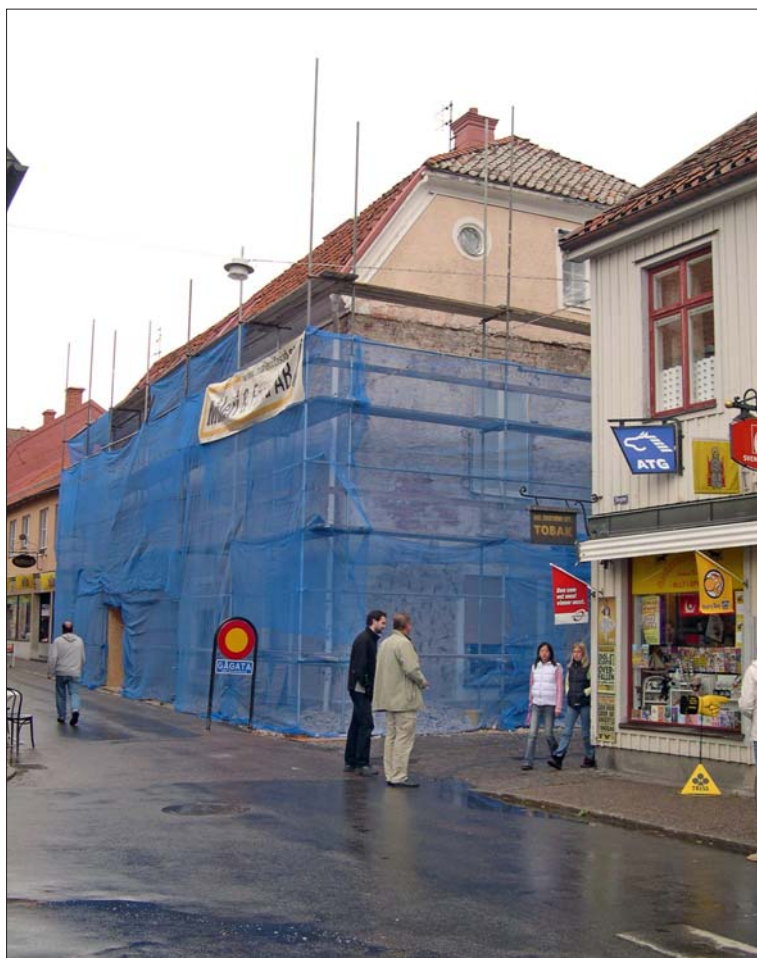
Figur 5. Omputsningsarbeten pågår i kv Handelsmannen 1. Byggnaden sedd från Rådhusorget i väster. Foto Ann-Charlott Feldt, ÖLM.
