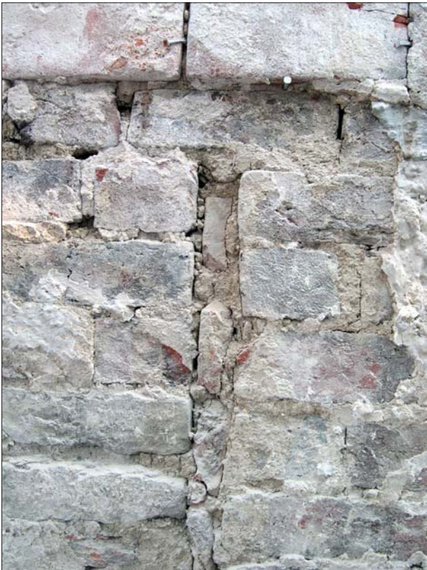
Figur 22. Utfyllnad av skarv i det senmedeltida tegelmurverket. Foto Ann-Charlott Feldt, ÖLM.
