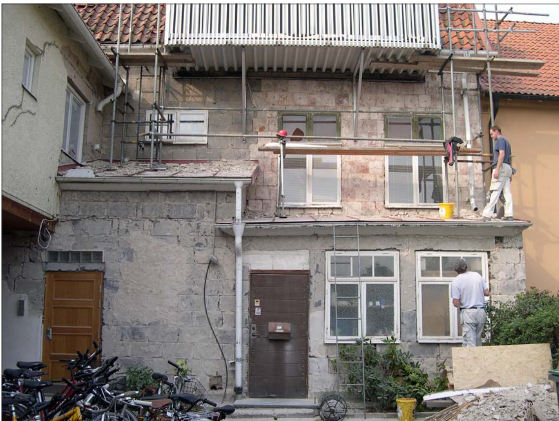
Figur 19. Fasad mot gården med spiktegel. Här syns även de fönsteröverdelar som upptäcktes under putsen vid arbetena 2005. Framför utbyggnaden finns en senare tillbyggnad från 1939. Foto Ann-Charlott Feldt, ÖLM.
