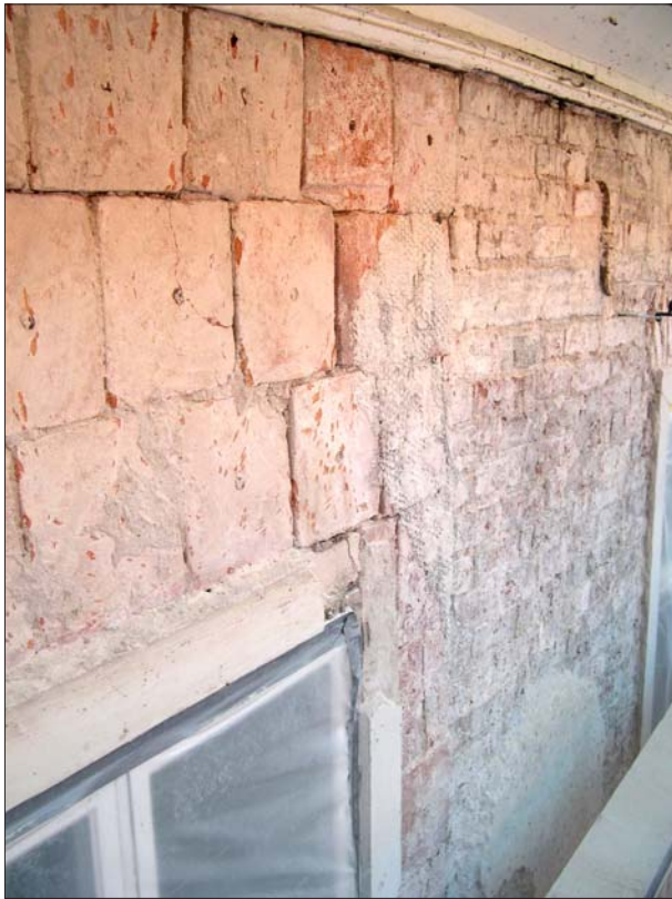
Figur 20. Spikteglets anslutning till ett samtida fönster och till det senmedeltida tegelmurverket. Foto Ann-Charlott Feldt, ÖLM.
