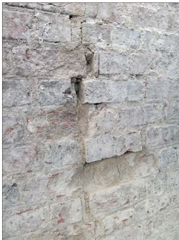
Figur 6. Tegelmurverk med stötfog i den sydvästra fasadens övre del. Foto Ann-Charlott Feldt, ÖLM.
