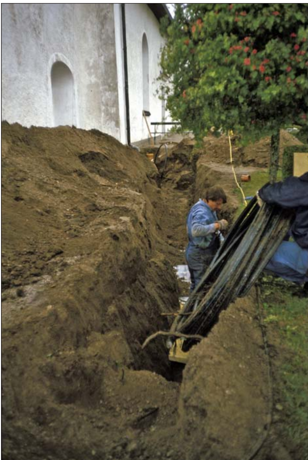
Ovan t v: Schakt I närmast södra långhusväggen.
