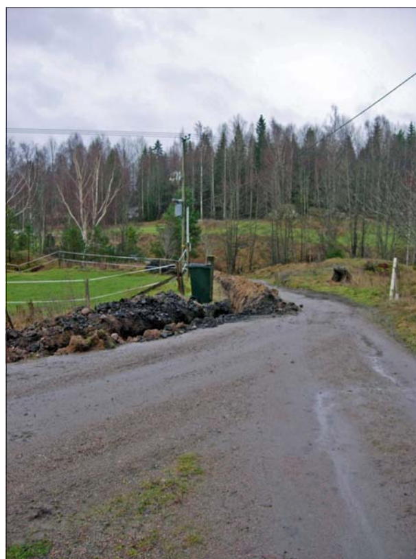
Figur 6. Kabelschaktet intill transformatorstolpe. Lager 1 synligt i schaktet. Fotot taget från norr. Foto Erika Räf, ÖLM.
