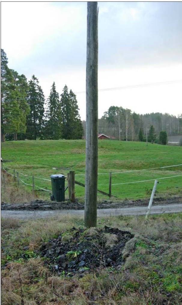
Figur 4. I samband med nedläggningen av jordkabel skulle luftledning raseras. Två av de befintliga luftledningsstolparna stod i varsitt slaggvarp. En av dem står kvar som fäste för ett kabelskåp. Den andra stolpen (bilden) kapades vid markytan och togs bort manuellt för att undvika ingrepp i fornlämningen. Fotot taget från väster. Foto Erika Räf, ÖLM.
