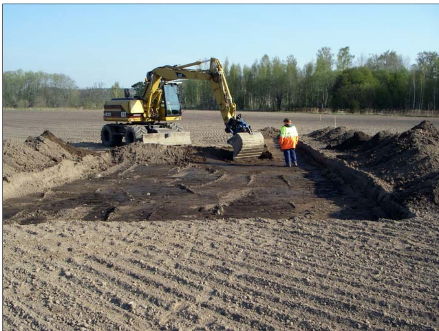
Figur 6. Framschaktning av en av de stora mörkfärgningarna. Foto Petter Nyberg, ÖLM.
