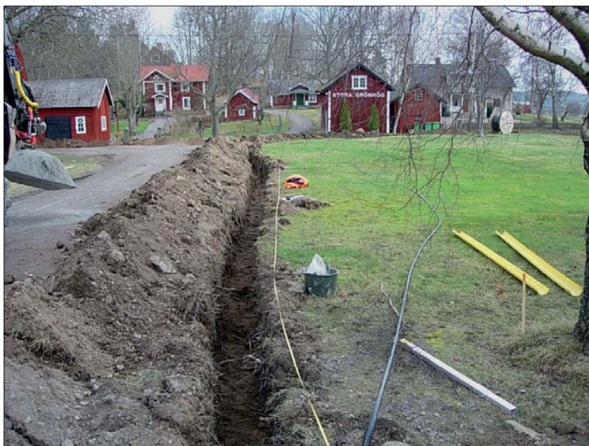
Figur 3. Schaktningsarbete vid Stora Grönhög. Bilden tagen mot NO. Foto ÖLM.
