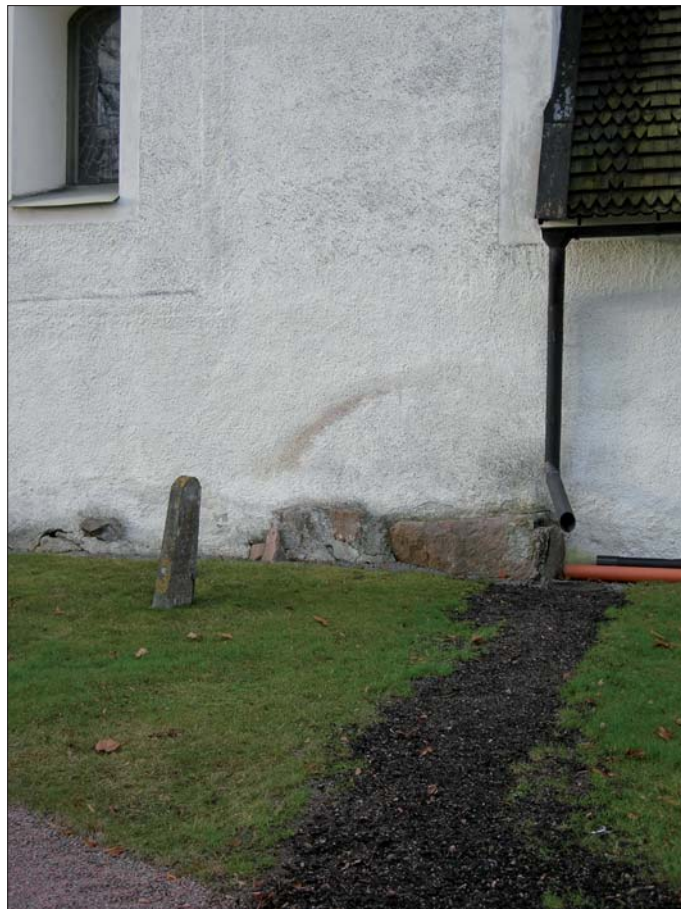
Figur 16. Nyligen återfyllt ledningsschakt till dagvattenbrunn vid korets nordöstra hörn. Foto: 2008-01-11 Anders Lundberg, ÖLM.
