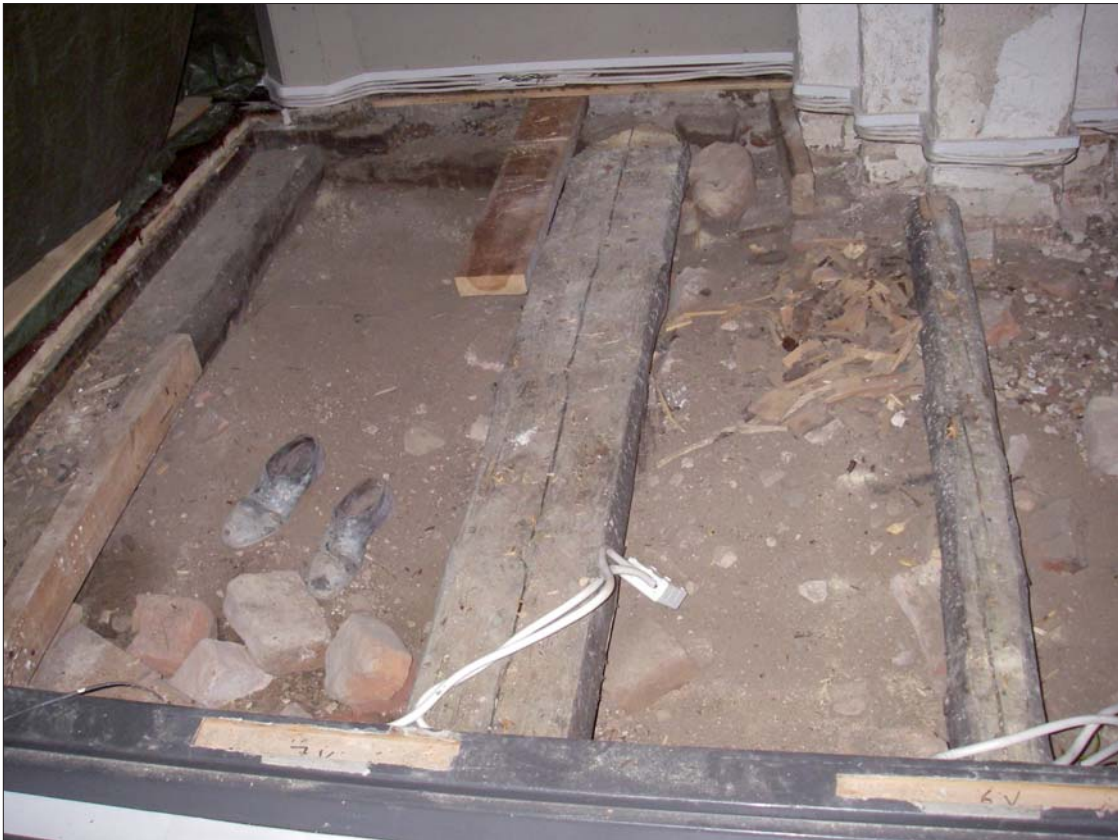
Figur 7. Fyllnadsmassor under trägolvet. Foto: 2007-12-17 Ann-Charlott Feldt, ÖLM.
