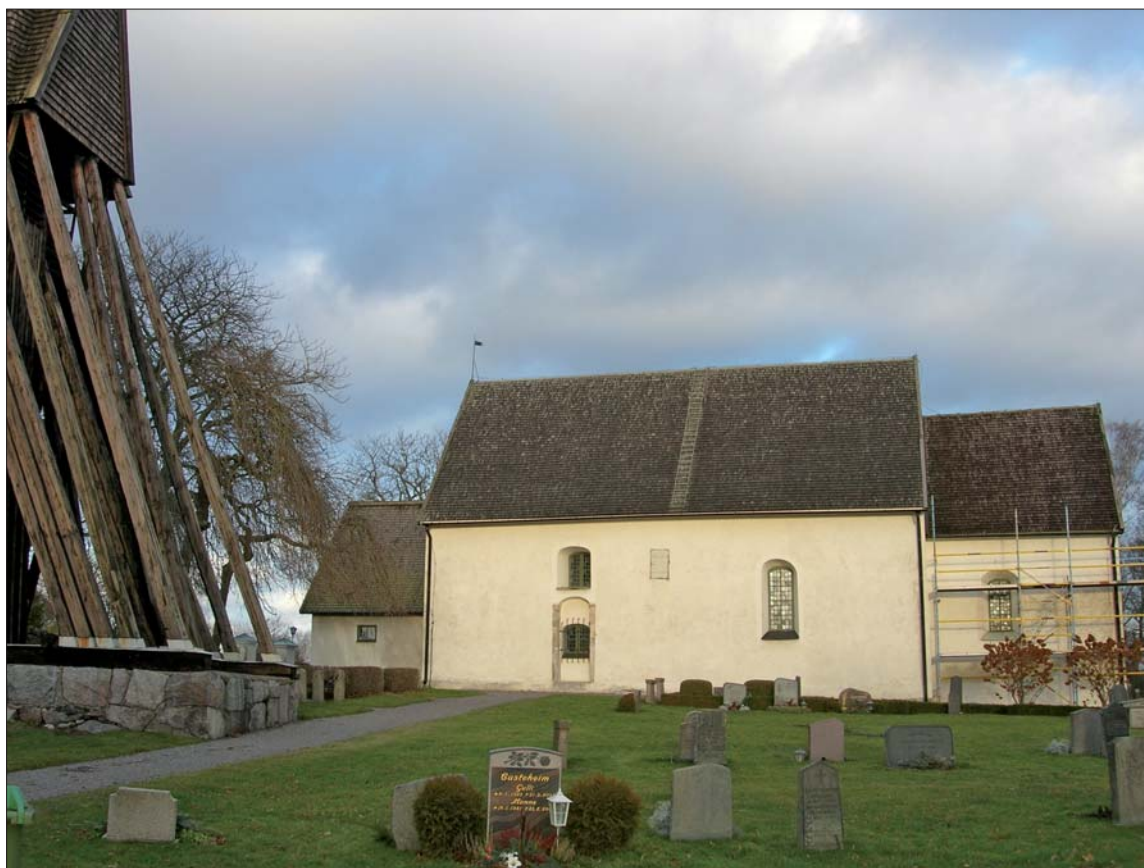
Figur 5. Kullerstads kyrka sedd från söder 2008-01-11. Foto: Anders Lundberg, ÖLM.
