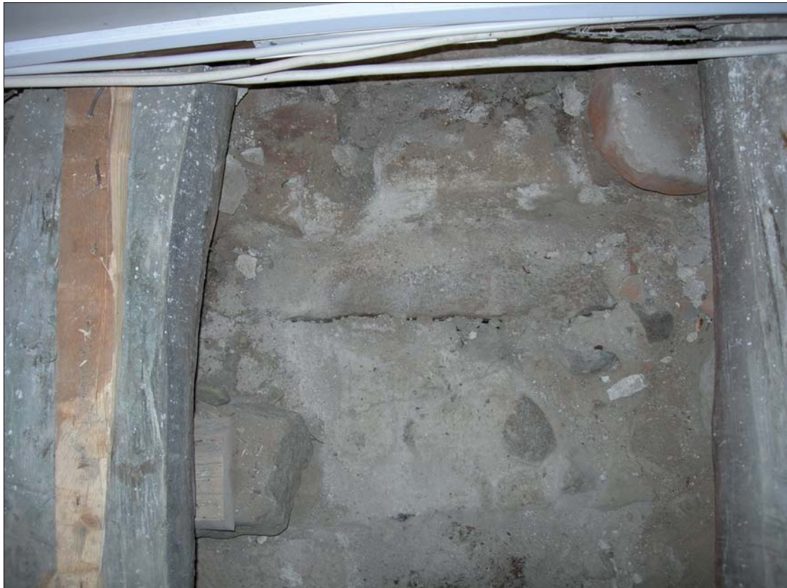
Figur 9. Bild av grundmurens avsats och anslutande kalkbruksgolv. Foto: 2008-01-11 Anders Lundberg, ÖLM.
