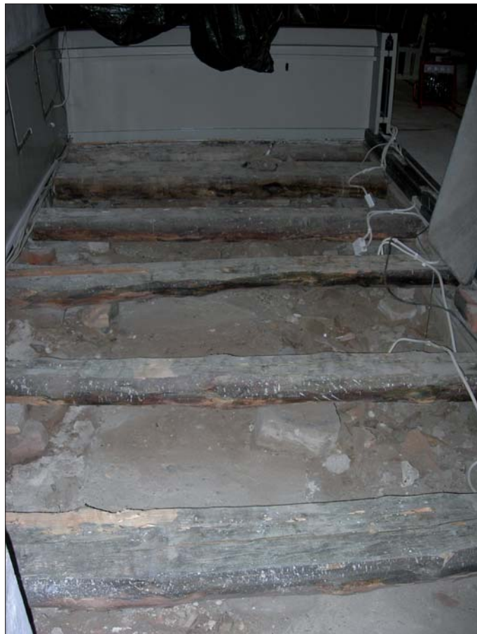
Figur 8. Översiktsbild av norra bänkkvarteret i östra travén med bjäklaget, dess underlagsstenar och en äldre golvnivå av kalkbruk exponerat. Foto: 2008-01-11 Anders Lundberg, ÖLM.
