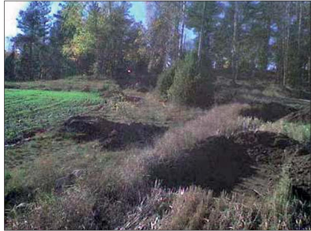
Figur 9. Schakt 10 i förgrunden med åssträckningen i bakgrunden. Foto mot väster, Titti Fendin, ÖLM.
